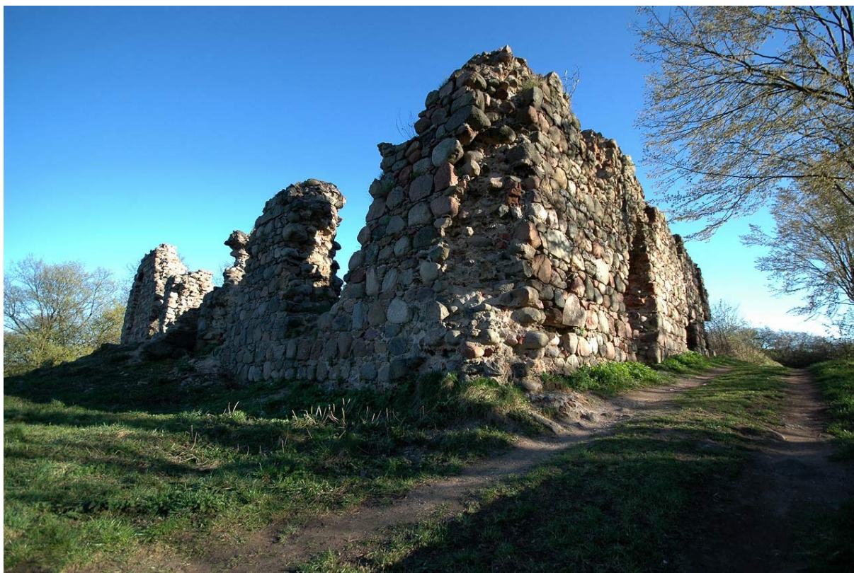
Ryc. 39 Pozostałości zamku w Kurzętniku
