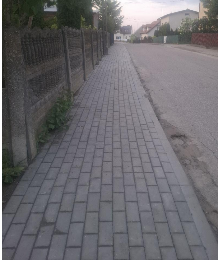
Przebudowa chodnika na ulicy Starowiejskiej w Marzęcicach
