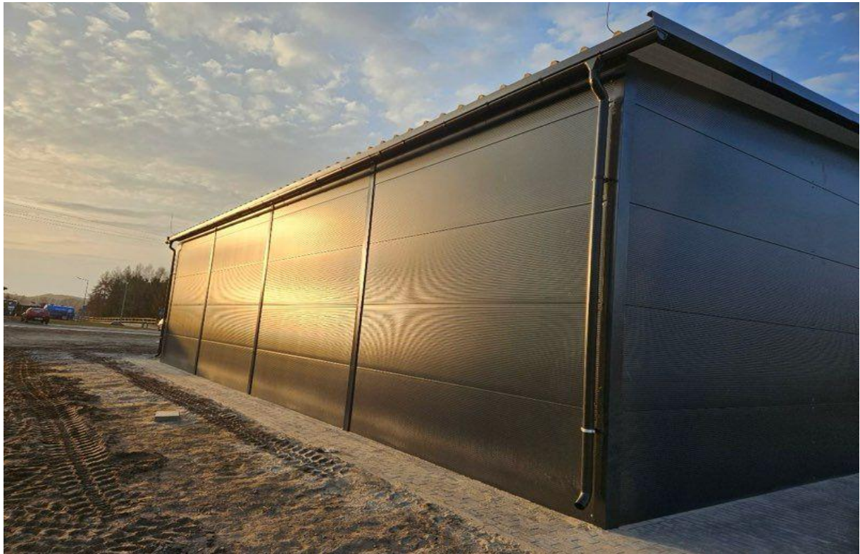
Budowa magazynu Obrony Cywilnej
