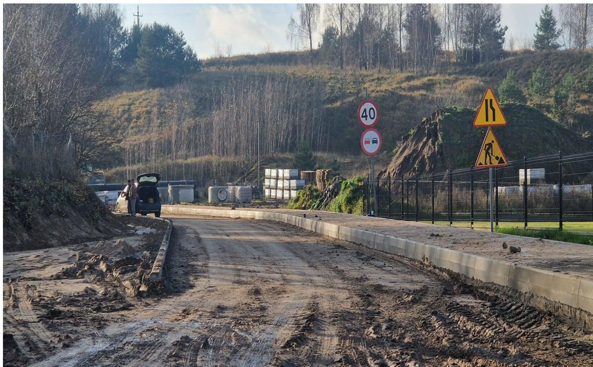
Budowa ulicy Polnej w Kurzętniku
