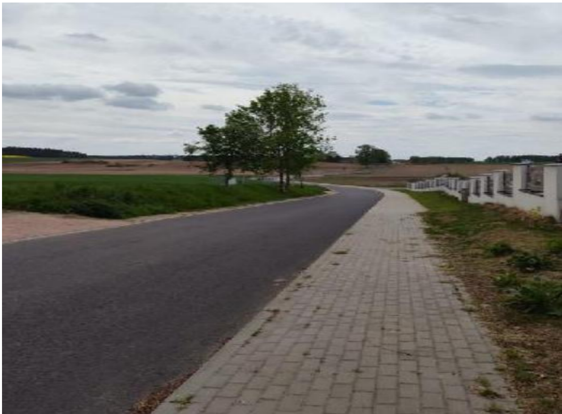
„Przebudowa drogi gminnej Marzęcice - Kamionka - Małe Bałówki - etap I”
