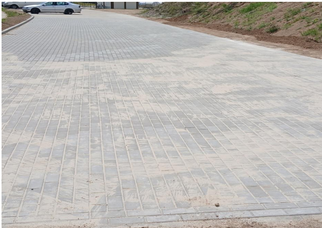
Budowa parkingu przy blokach TBS i GZOW ul. Kościuszki (dz. nr 1764/2)
