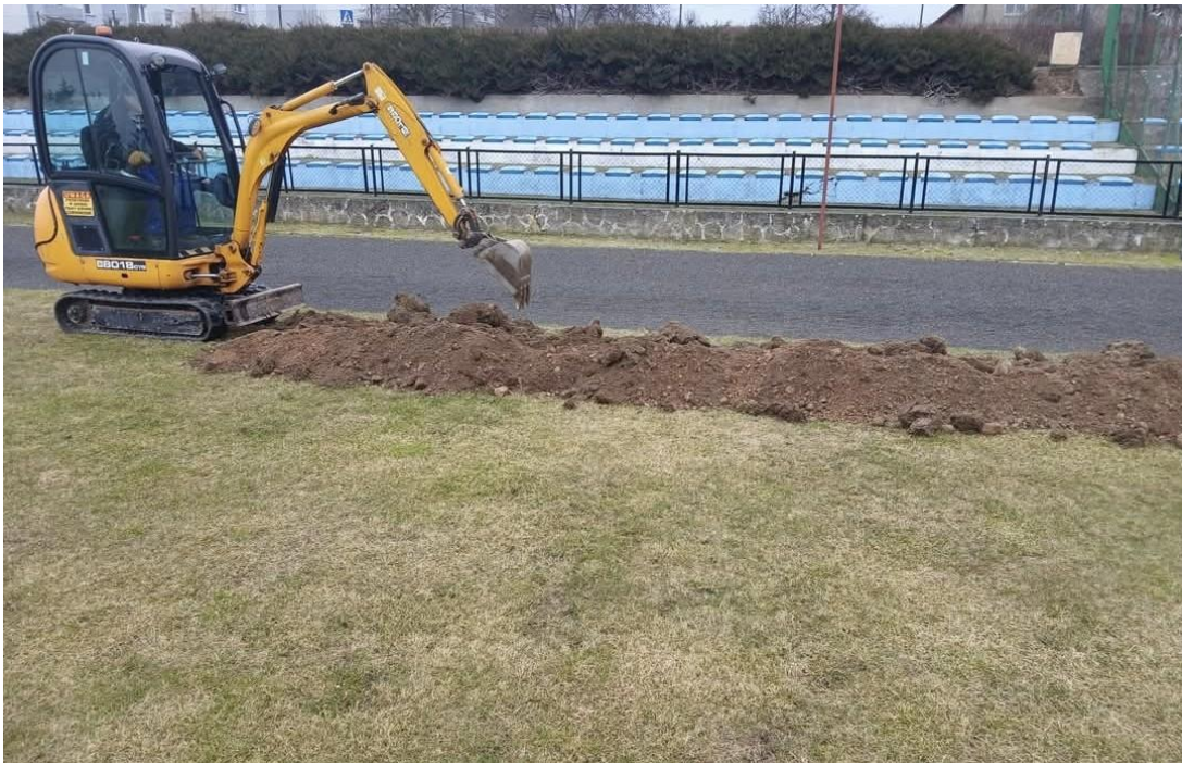
Stworzenie systemu nawadniania stadionu w Kurzętniku
