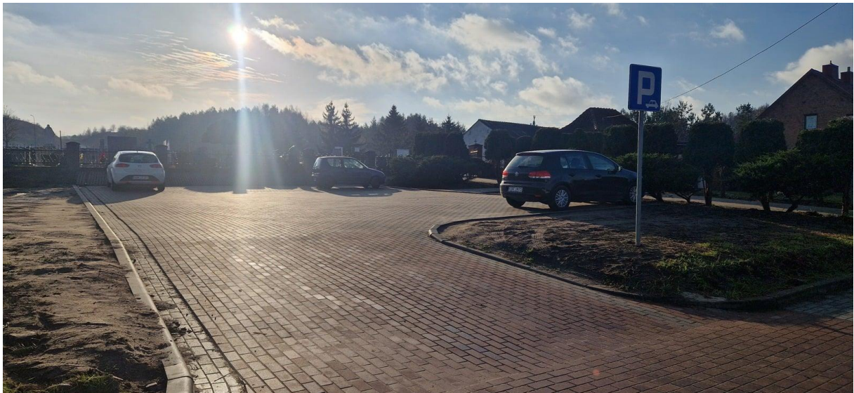
Budowa parkingu przy ul. Grunwaldzkiej w Kurzętniku (dz. 1695, 292) – etap I
