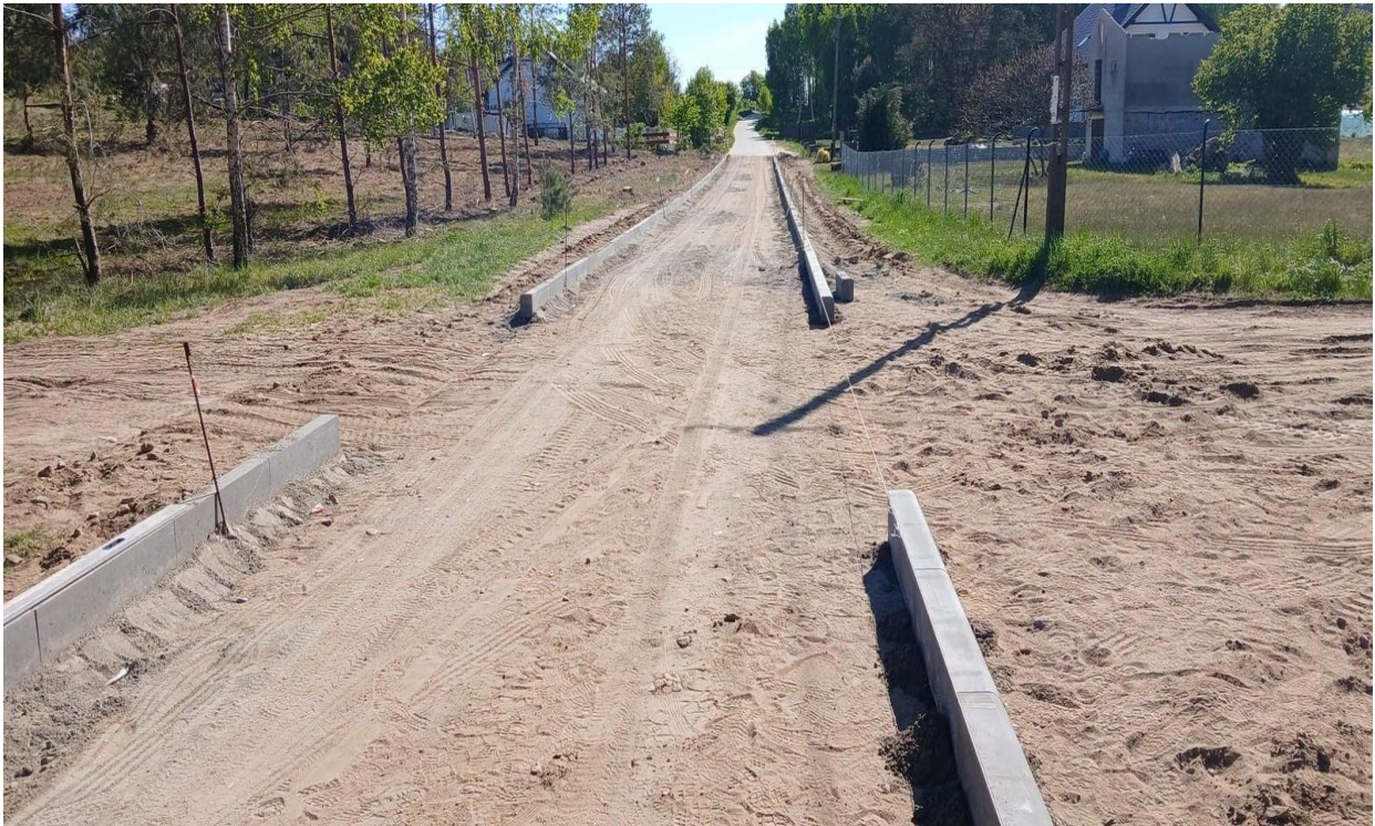
Przebudowa drogi gminnej dz. nr 41/1
