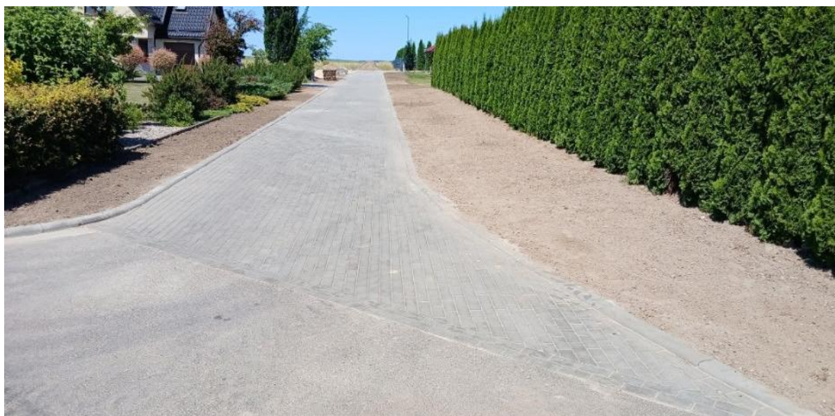
Przebudowa drogi w Brzoziu Lubawskim dz. nr 488/6
