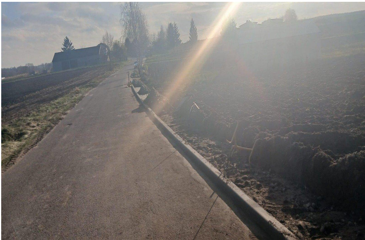
Przebudowa drogi gminnej Nr 182001N w Otrębie polegająca na budowaniu chodnika
