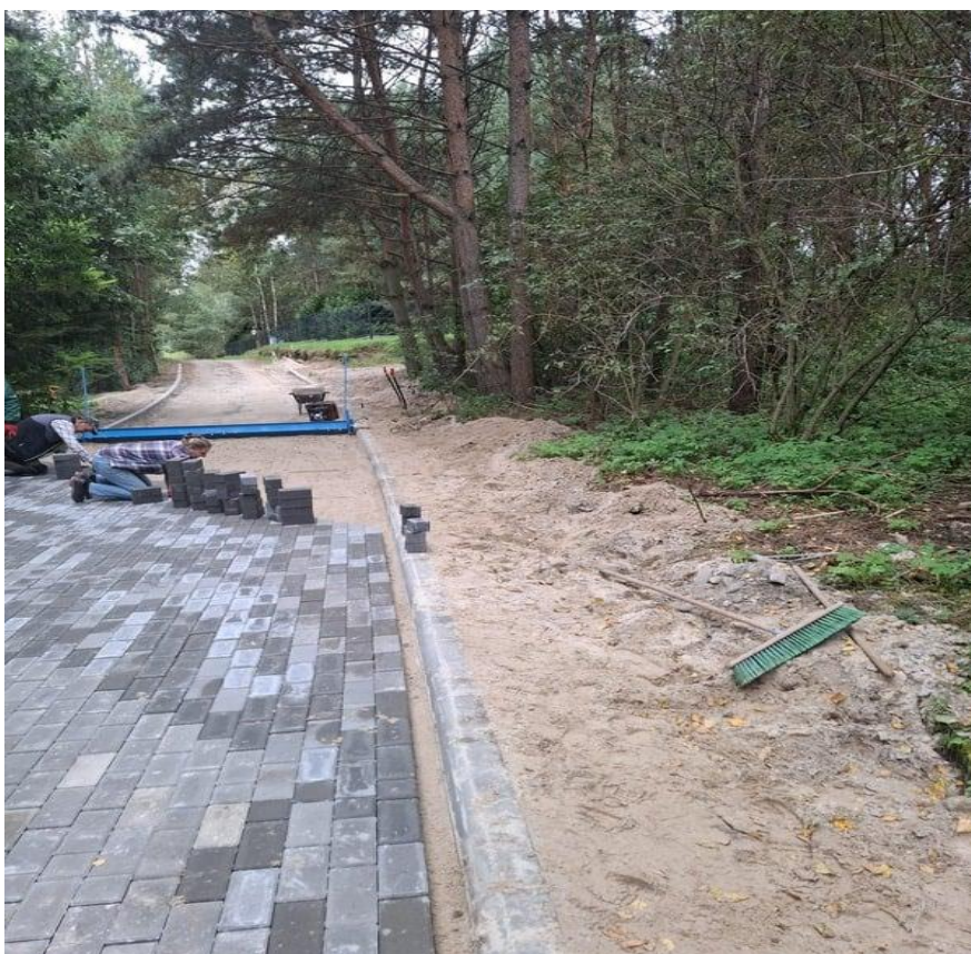
Przebudowa drogi gminnej w Kącikach dz. Nr 78
