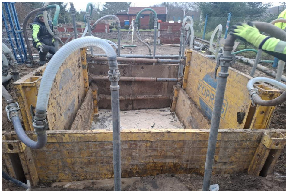
Budowa wodociągu i kanalizacji sanitarnej w Kurzętniku dz. nr 1225, 1226 i 1067/16
