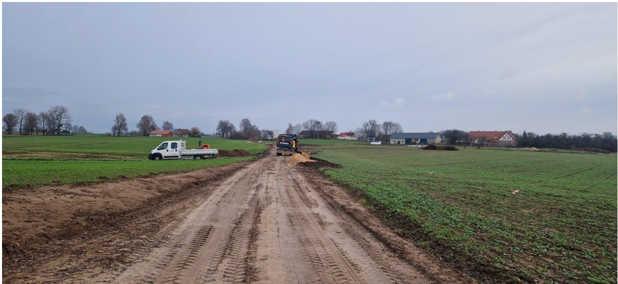
Przebudowa drogi gminnej Tomaszewo-Wielkie Bałówki
