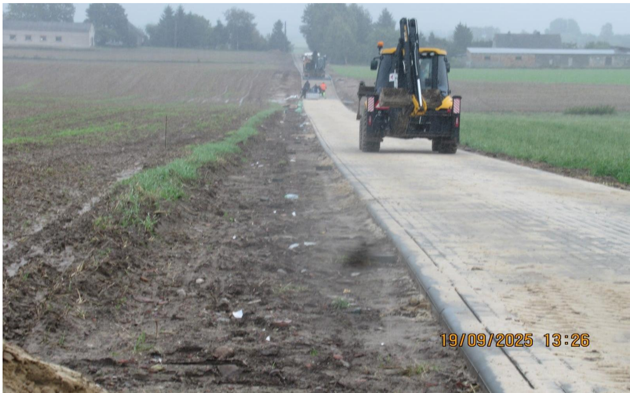
Przebudowa drogi gminnej dz. nr 147 w miejscowości Wawrowicach
