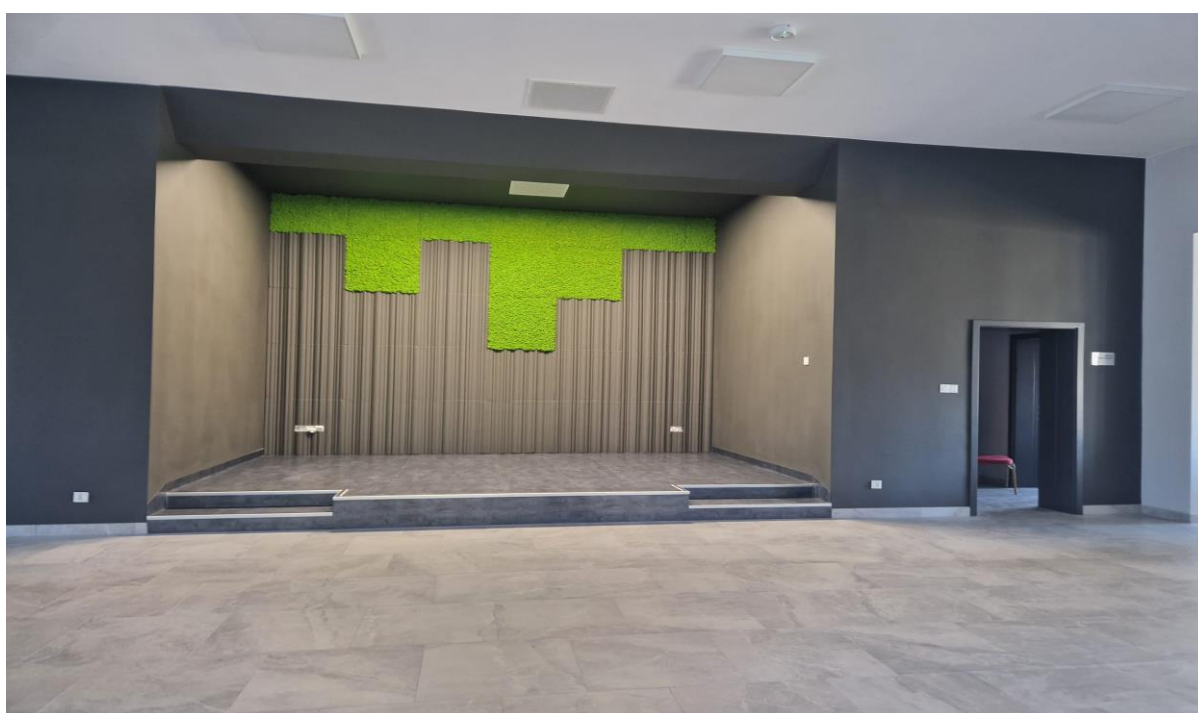
Rozbudowa i przebudowa istniejącego budynku świetlicy wiejskiej z remizą OSP w Marzęcicach
