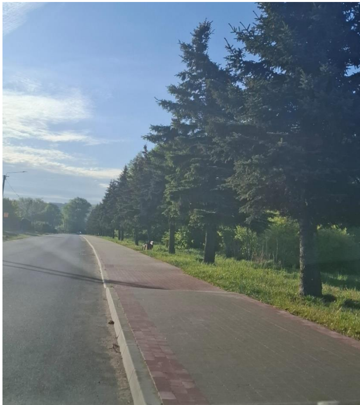
chodnik ul. Dworcowa w Kurzętniku
