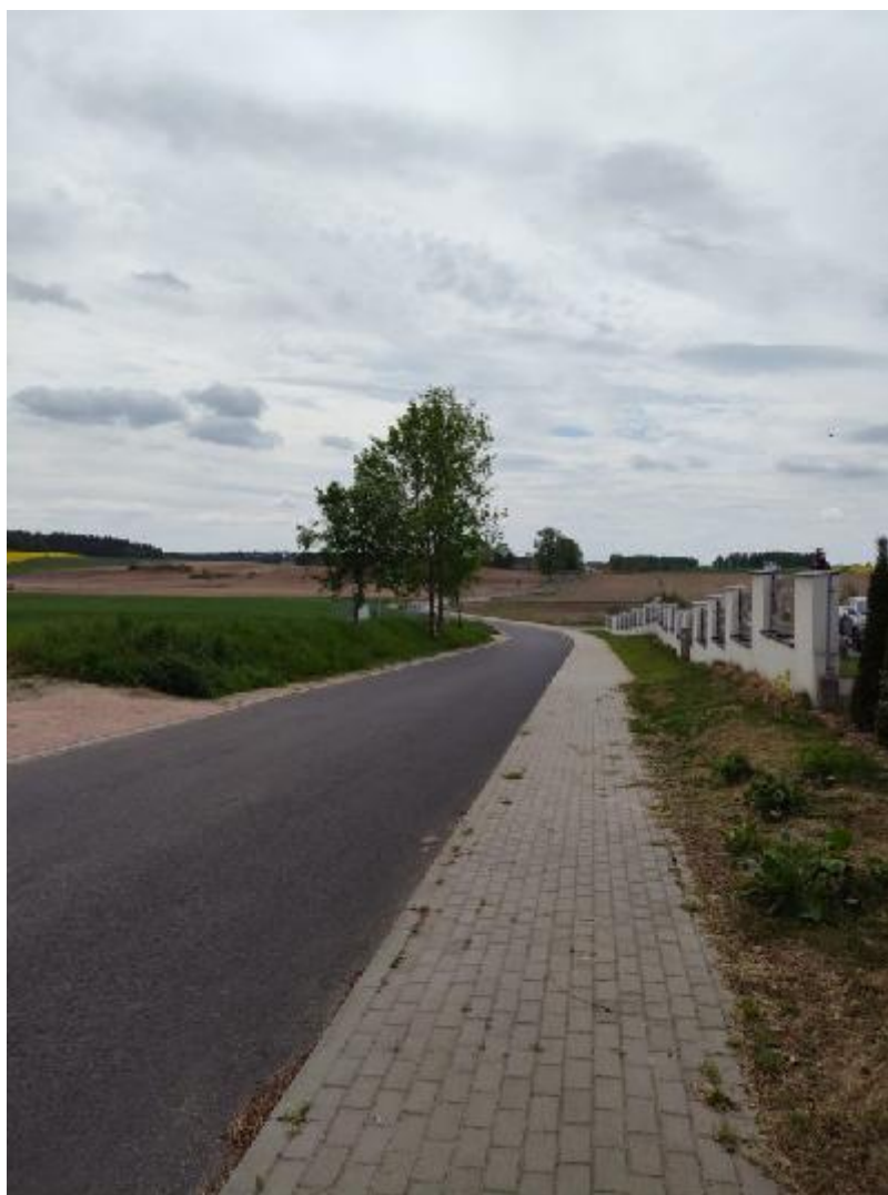
Przebudowa drogi gminnej Marzęcice - Kamionka - Małe Bałówki - etap I
