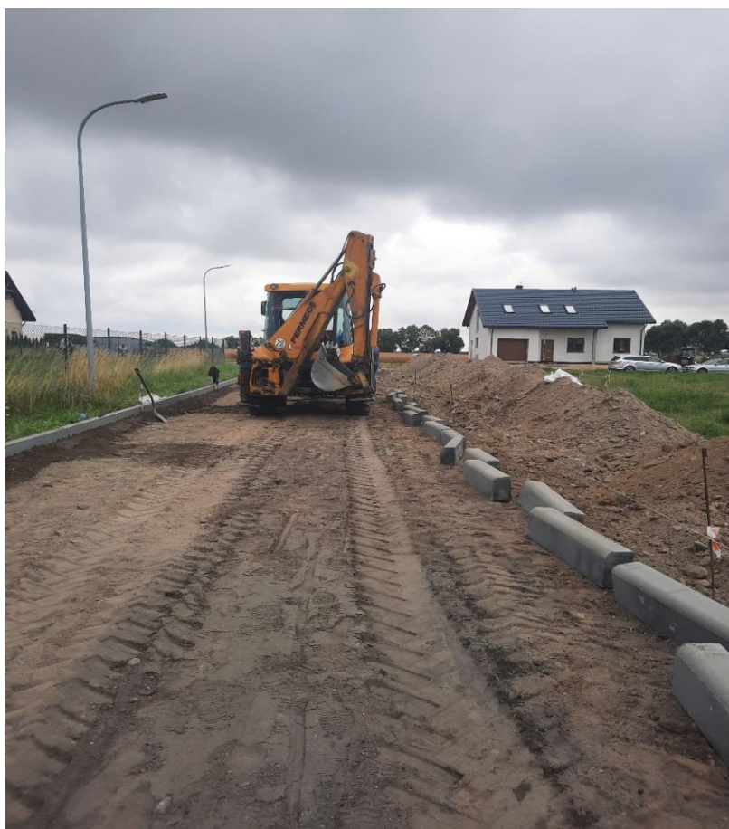
Przebudowa drogi dz. nr 604/15, odcinek od drogi powiatowej do boiska Brzozie Lubawskie
