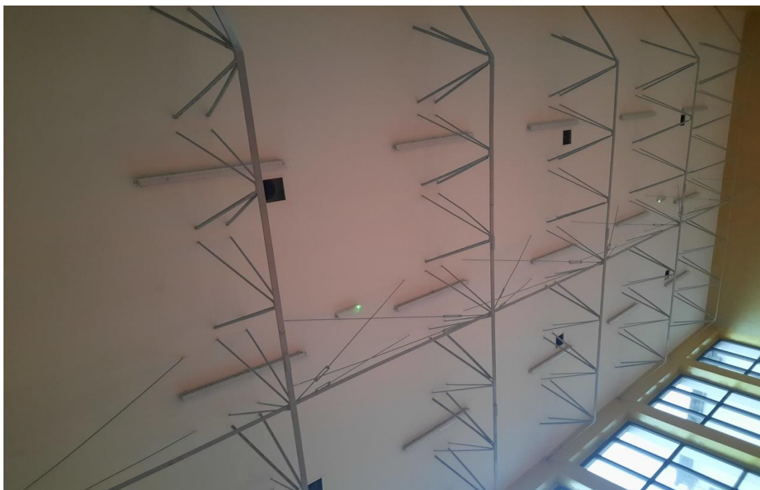
Sufit podwieszany w ramach „Modernizacja sali gimnastycznej w Zespole Szkół im. Władysława Jagiełły w Kurzętniku”
