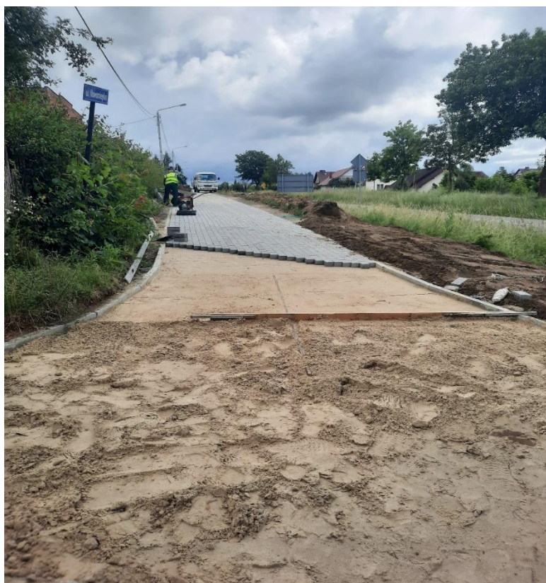
Budowa chodnika od straży do ulicy Okrężnej (Marzęcice)
