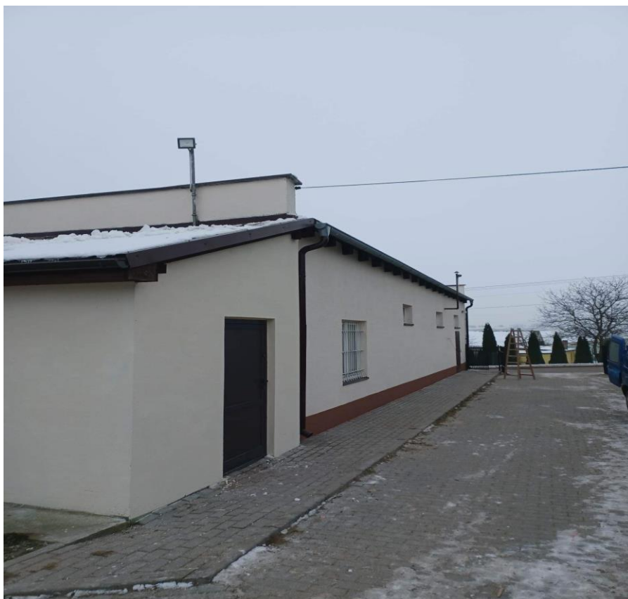
Modernizacja remizy OSP w Krzemieniewie
