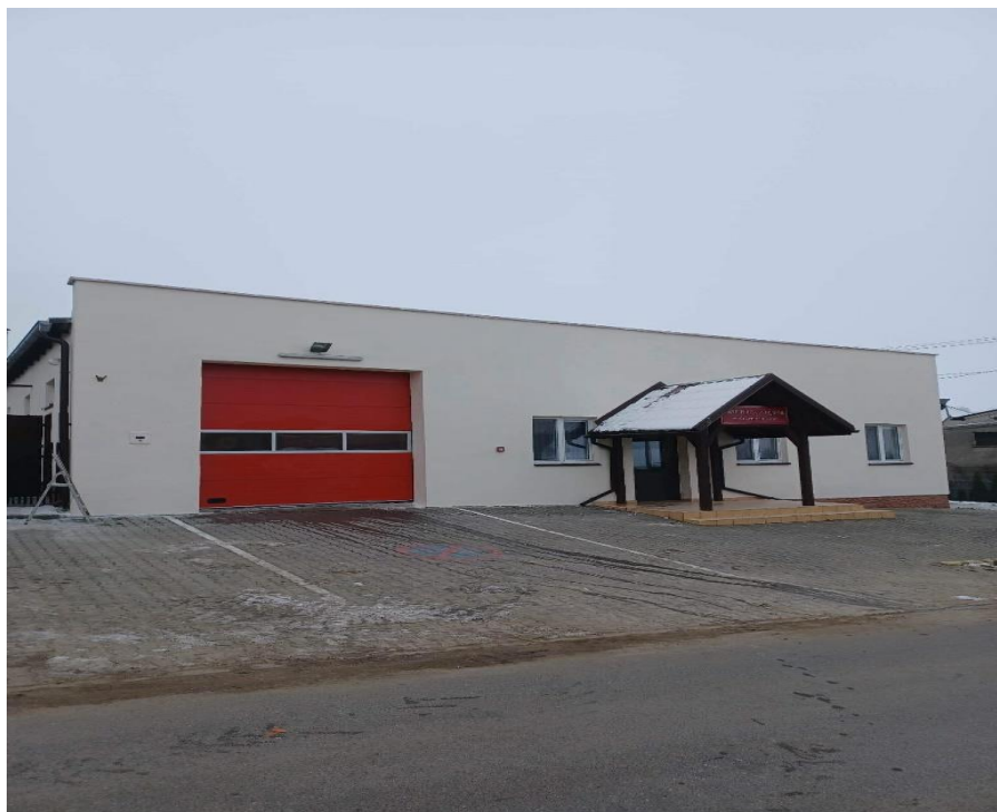
Modernizacja remizy OSP w Krzemieniewie
