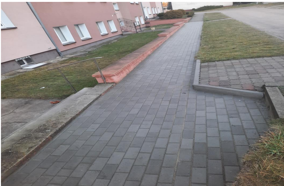
Budowa chodnika ul. Sienkiewicza (przed blokami EXPOM)
