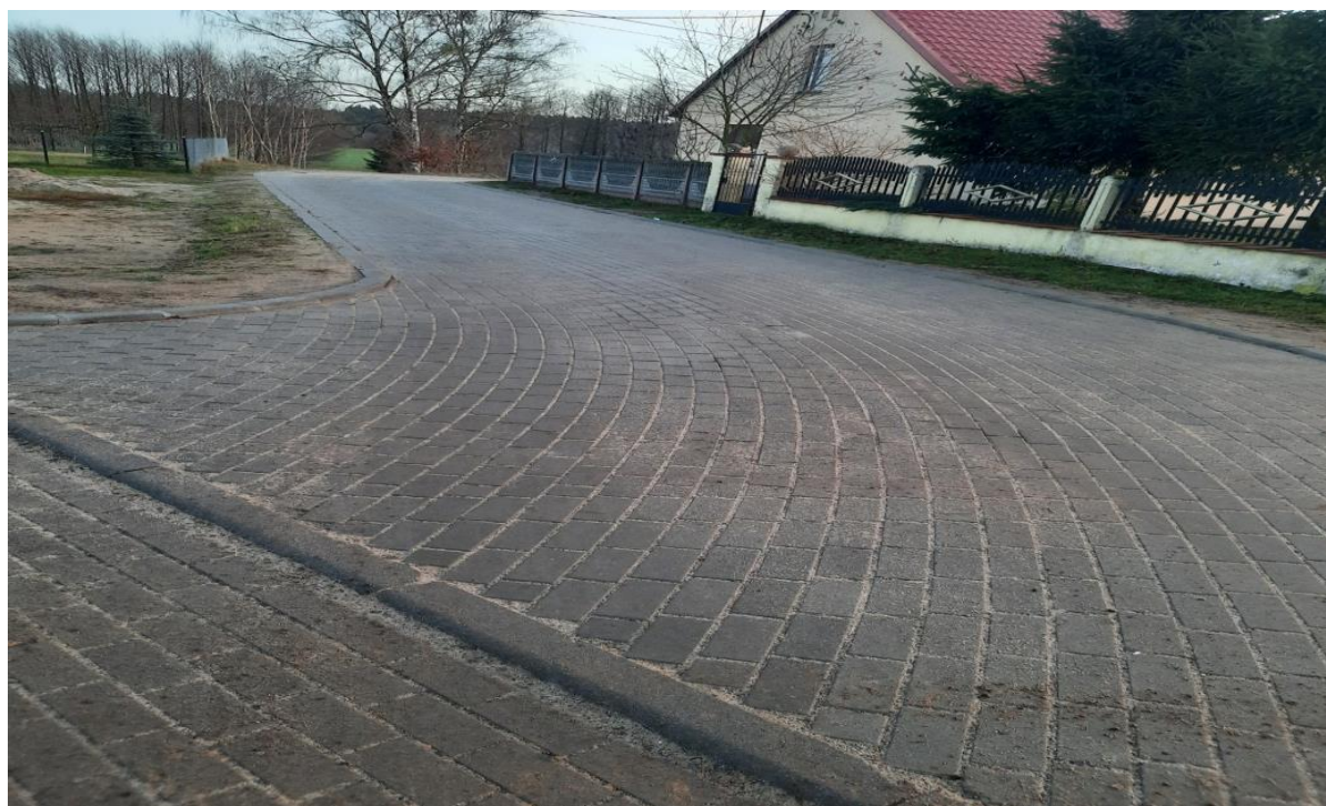
Przebudowa drogi osiedlowej na działce nr 115/1- Lipowiec
