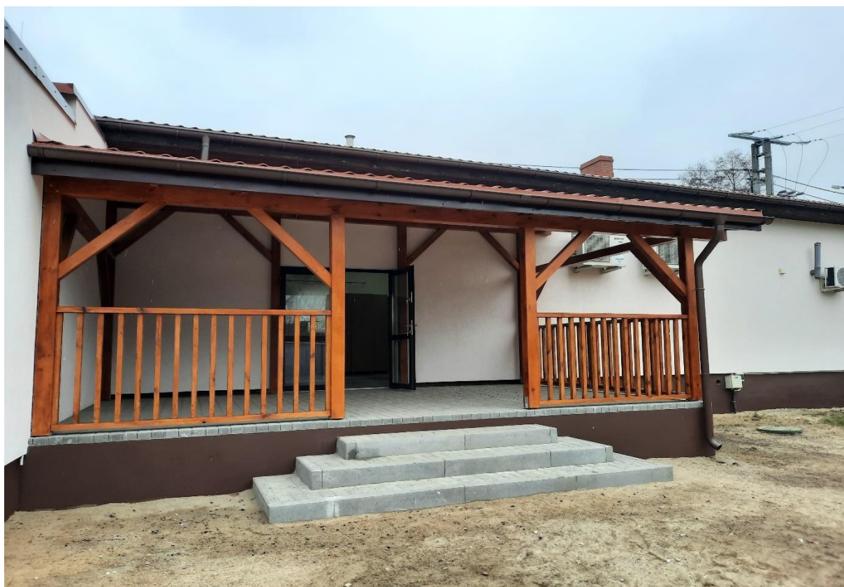
„Aktywna świetlica” – Remont świetlicy w Nielbarku wraz z budową wiaty wolnostojącej
