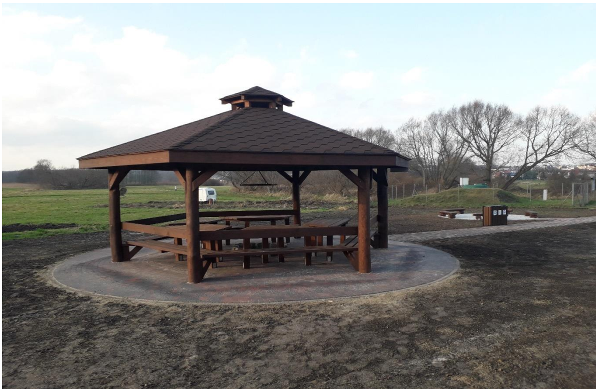
Rozbudowa stacji wodnej dla kajaków w Kurzętniku
