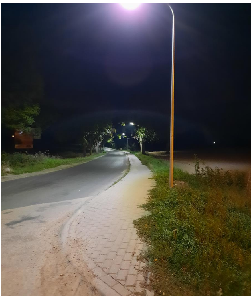
Budowa oświetlenia ulicznego ulicy Ogrodowej – Kurzętnik 1
