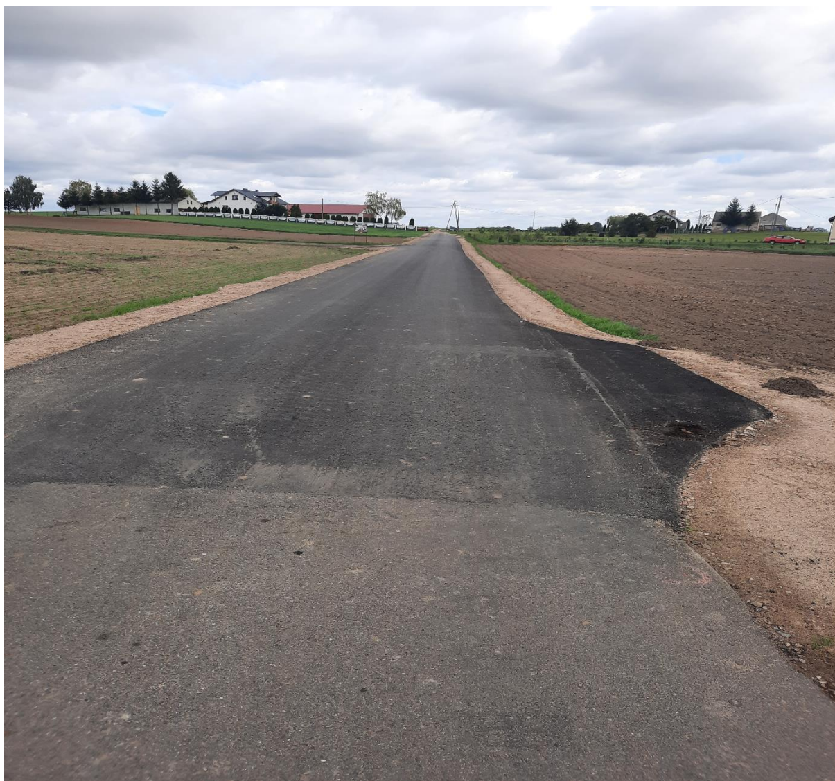
Przebudowa drogi gminnej Otręba dz. nr 163
