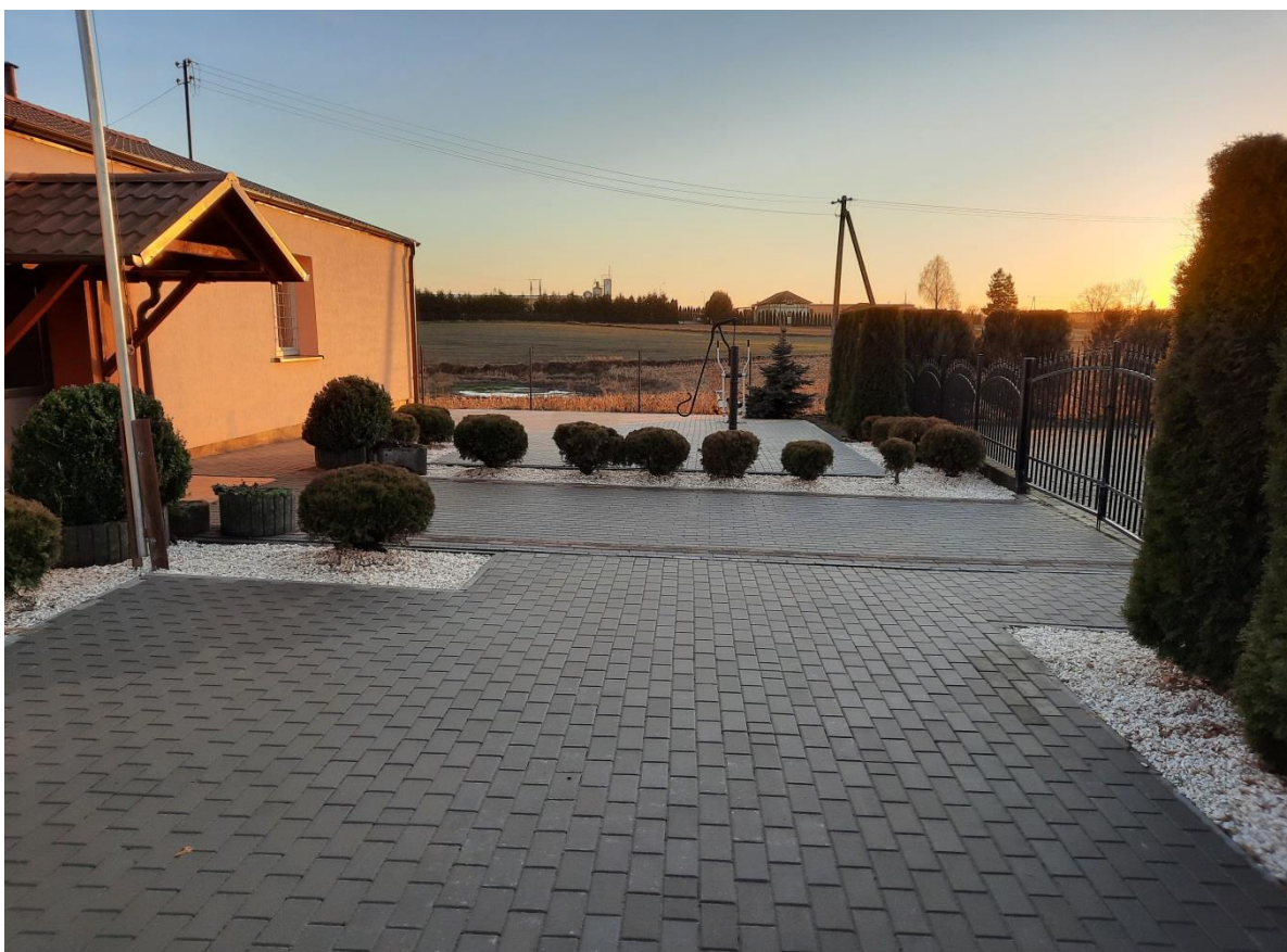
Wykonanie chodnika przy świetlicy wiejskiej – Fundusz Sołecki Małe Bałówki
