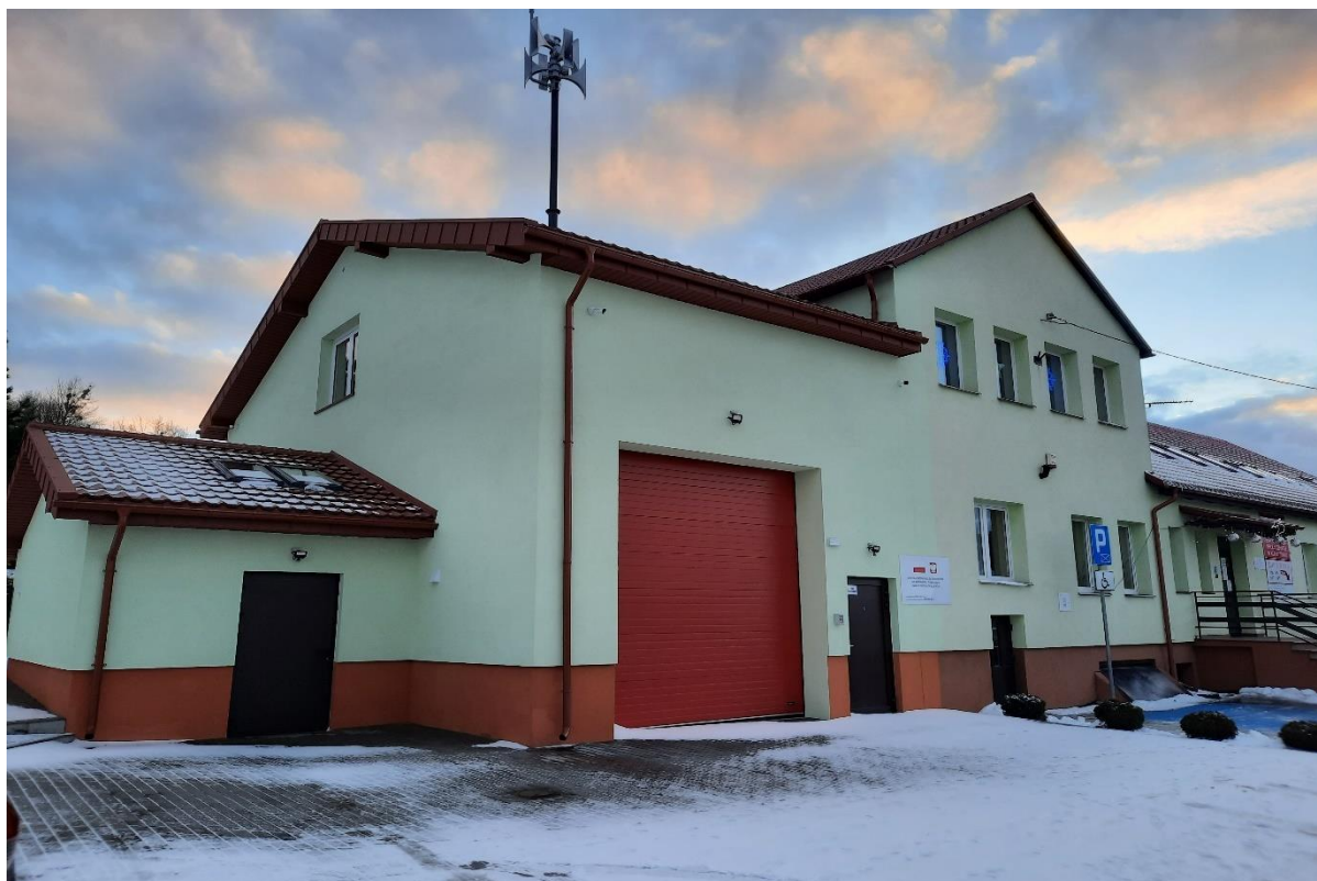
Rozbudowa Gminnego Centrum Kultury w Kurzętniku o remizę OSP
