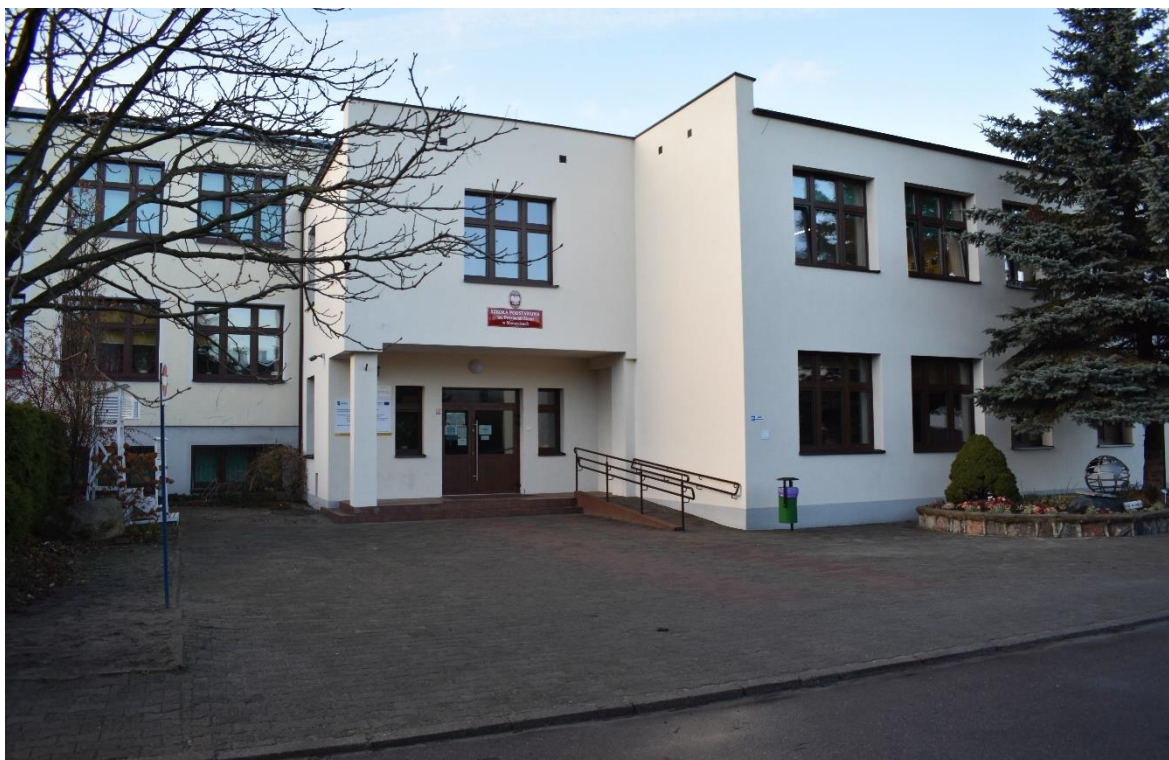
Poprawa efektywności energetycznej w budynku Szkoły Podstawowej w Marzęcicach
