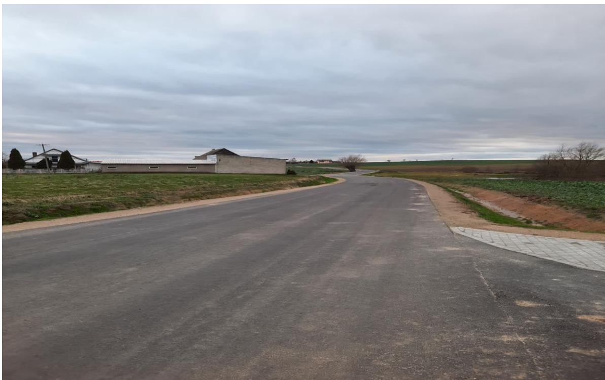
Przebudowa drogi gminnej stanowiącej dz. nr 78/1 w miejscowości Wawrowice
