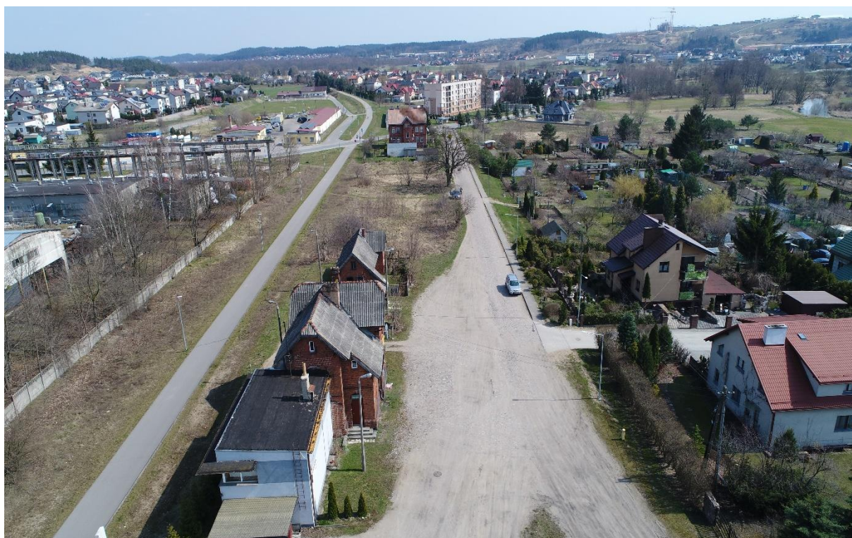
Oświetlenie drogowe ul. Dworcowa w Kurzętniku
