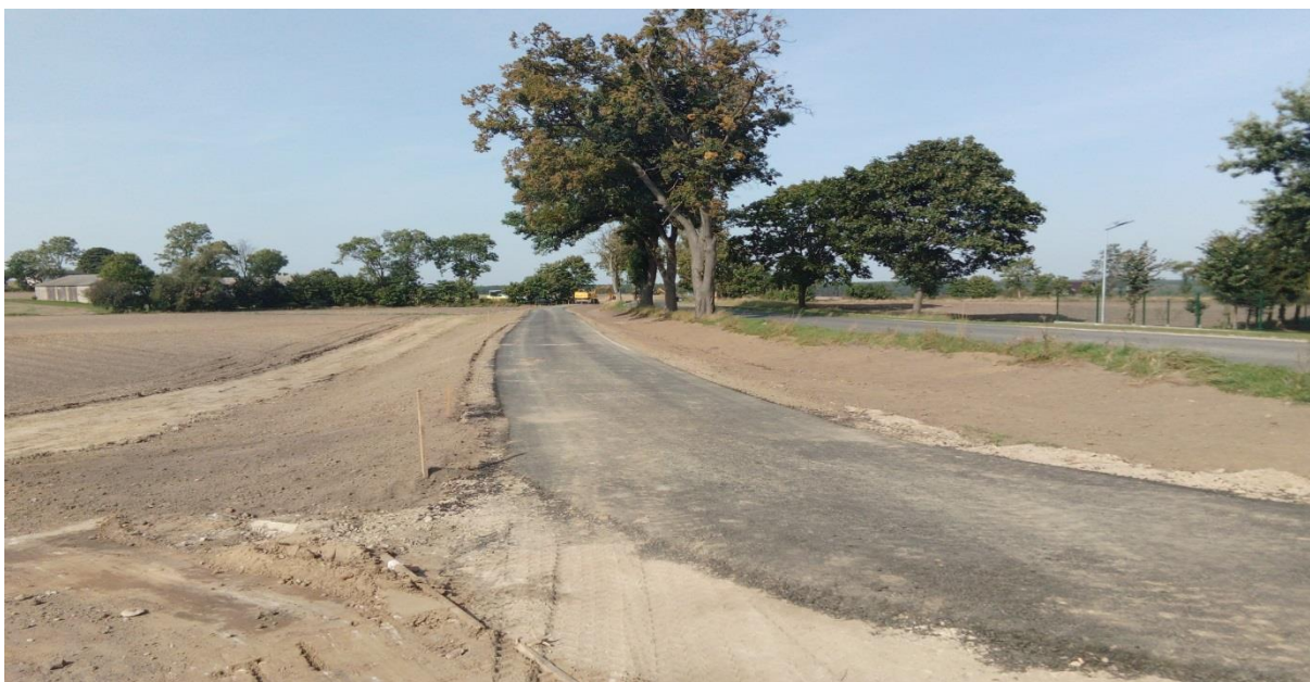
Budowa ciągu pieszo-rowerowego w Wawrowicach
