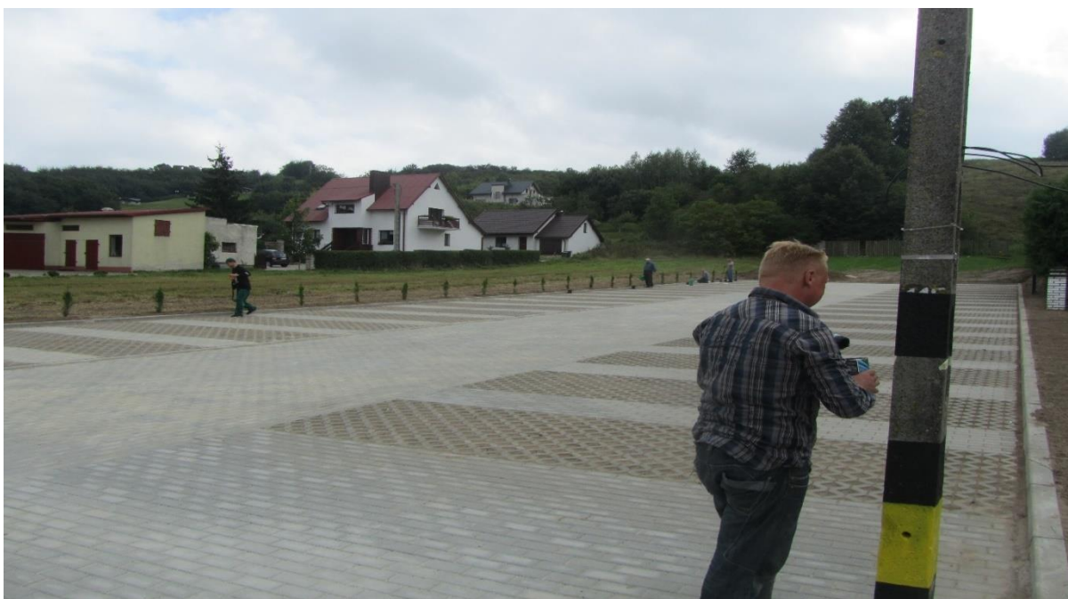
Utwardzenie terenu przy ul. Kościuszki
