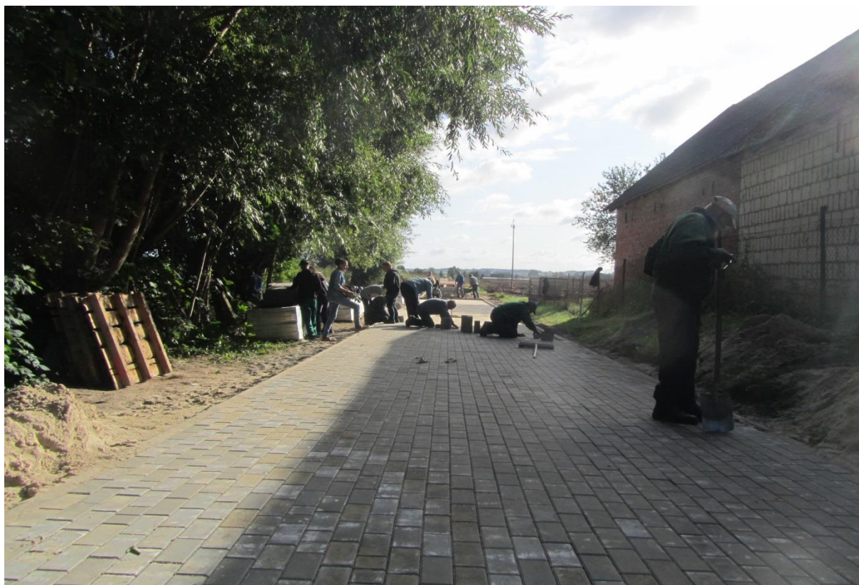
Wawrowice - przebudowa dróg dz. nr 115, 147
