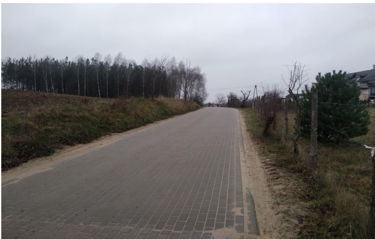
Szafarnia - utwardzenie dróg działka 41/1
