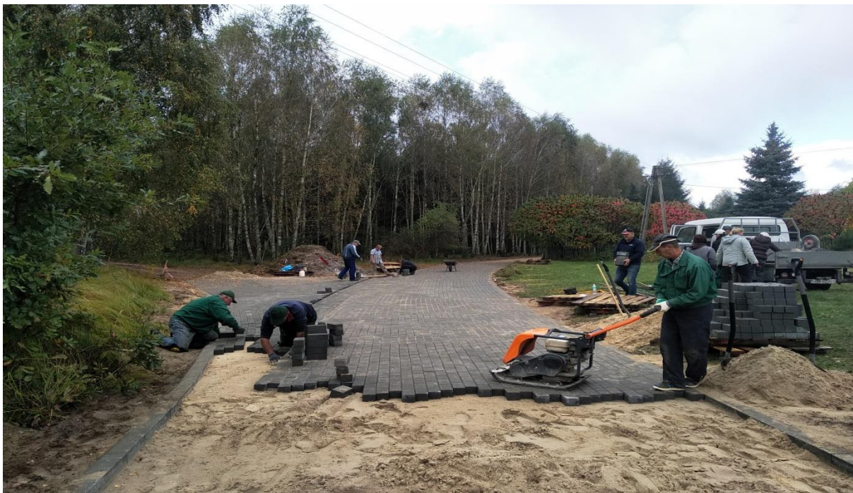
Tereszewo - budowa drogi gminnej na działce nr 469/2 i 468/2 - etap II
