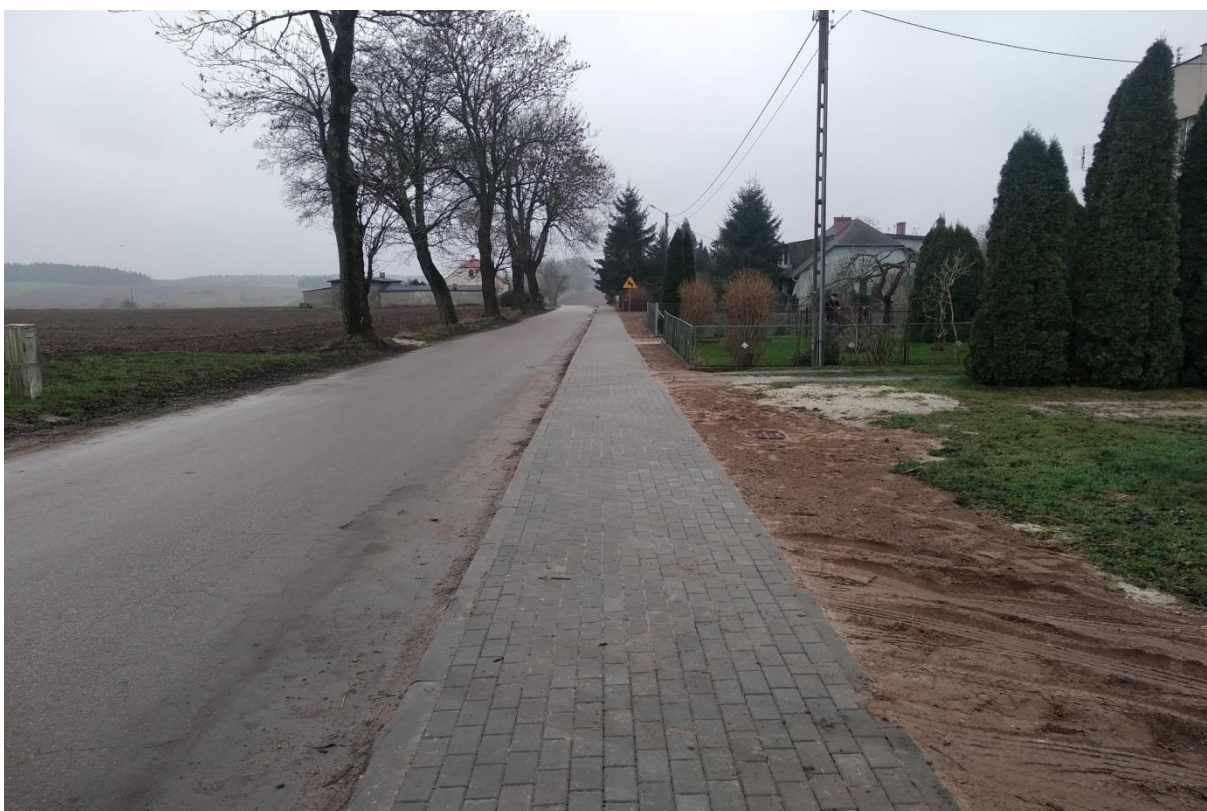
Marzęcice - uregulowanie rowu drogowego na ul. Pod Kamionkę
