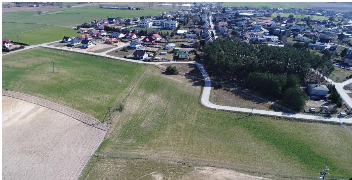
Przebudowa ulicy Szkolnej, Okólnej, Okrężnej oraz drogi stanowiącej działkę nr 9/47 - Marzęcice
