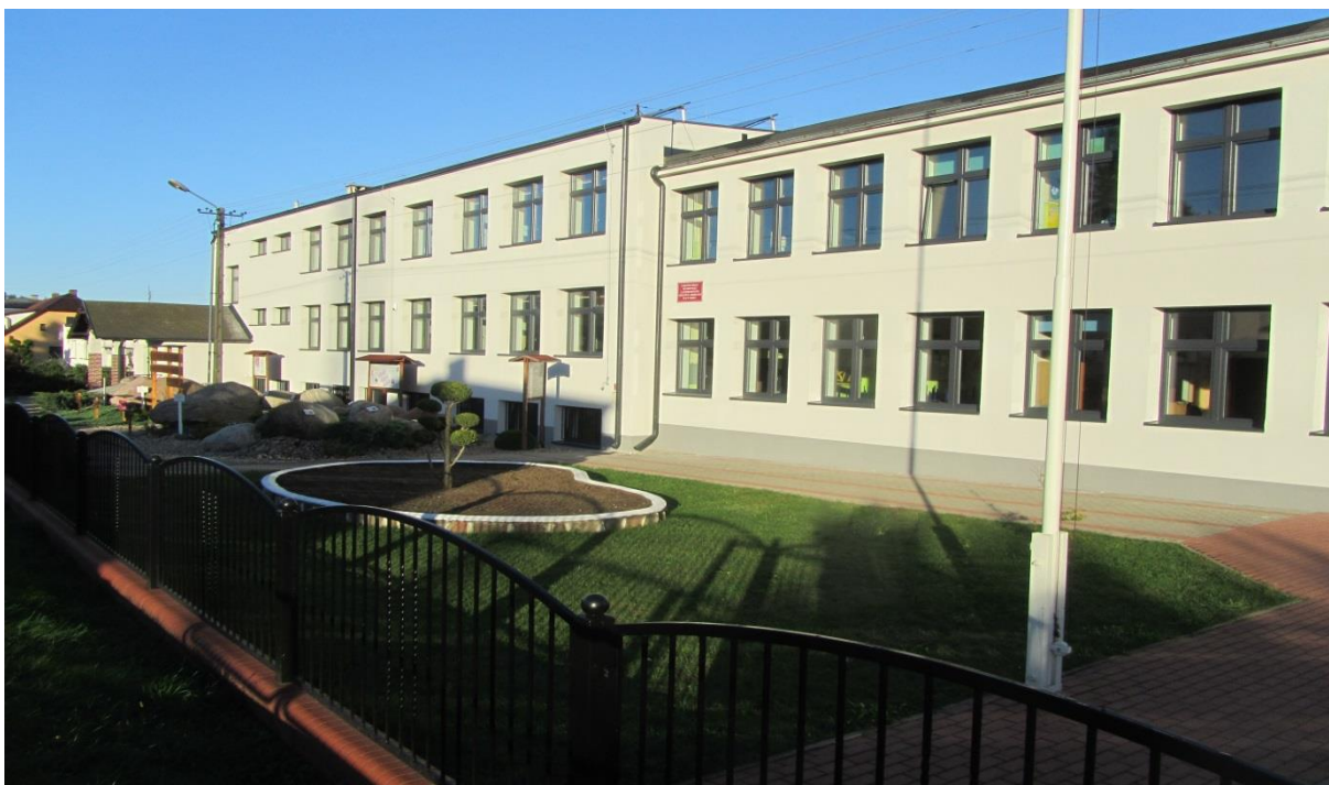
Budynek Zespołu Szkół w Kurzętniku
