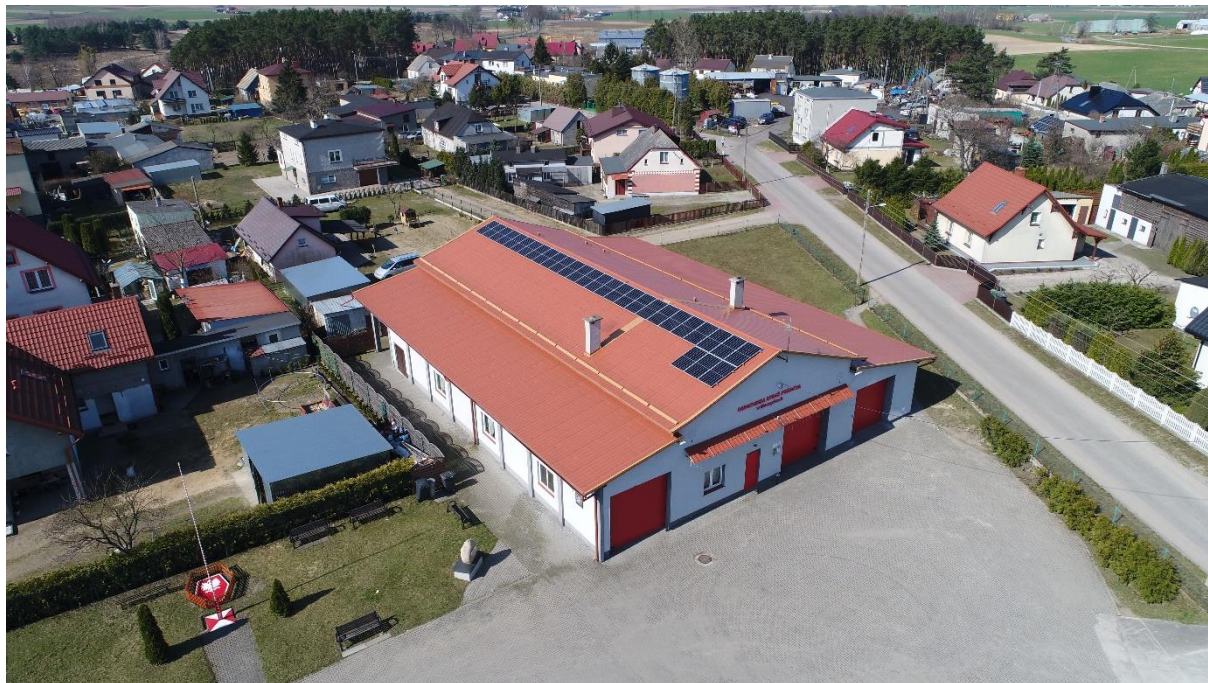
Panele fotowoltaiczne na dachu remizy strażackiej w Marzęcicach
