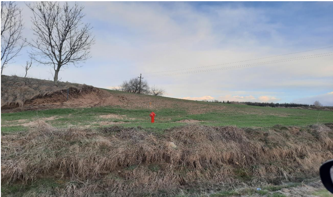
Wodociąg na ulicy Polnej w Kurzętniku
