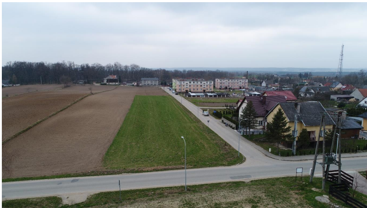
Oświetlenie drogowe ulica Parkowa oraz ulica Wiejska w Kurzętniku
