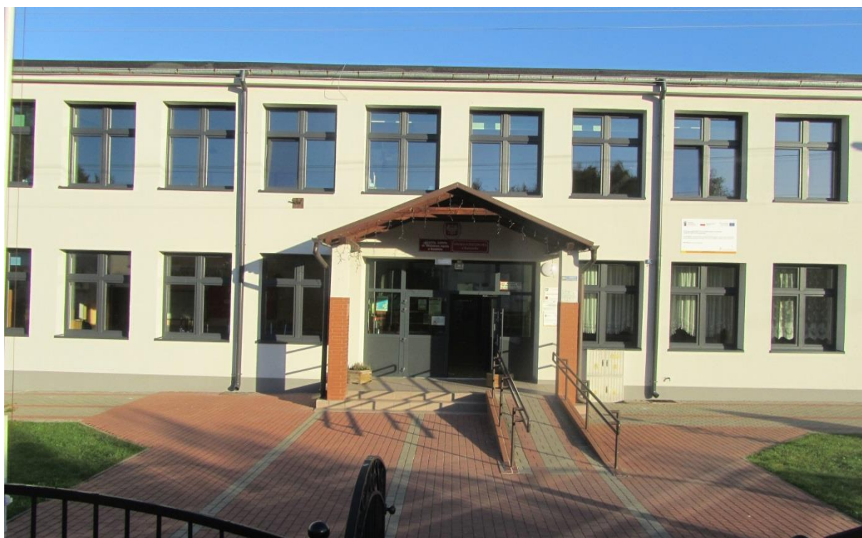
Budynek Zespołu Szkół w Kurzętniku
