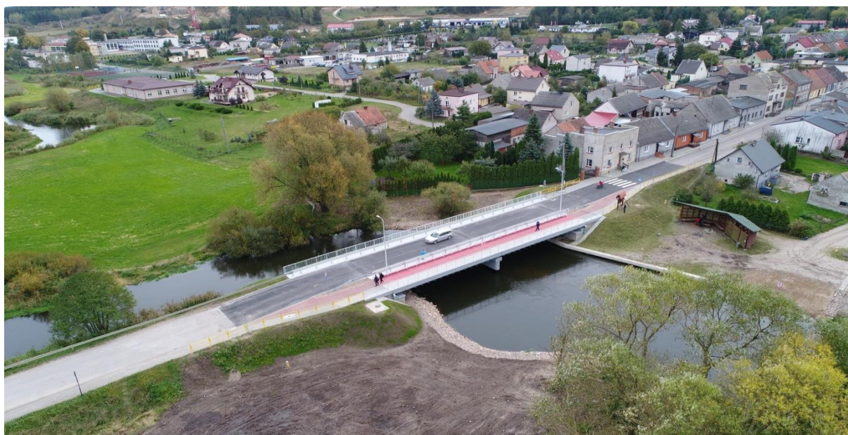
Mostu drogowego w Kurzętniku, ul. Hunta – Dworcowa
