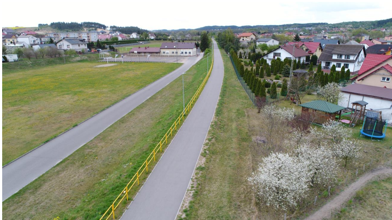
Utworzenie ścieżki rowerowej z Kurzętnika do Kaługi wraz z infrastrukturą towarzyszącą - Etap I
