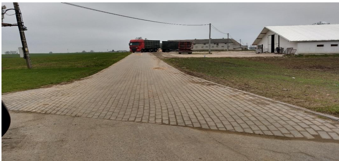
Przebudowa dróg gminnych w Wawrowicach
