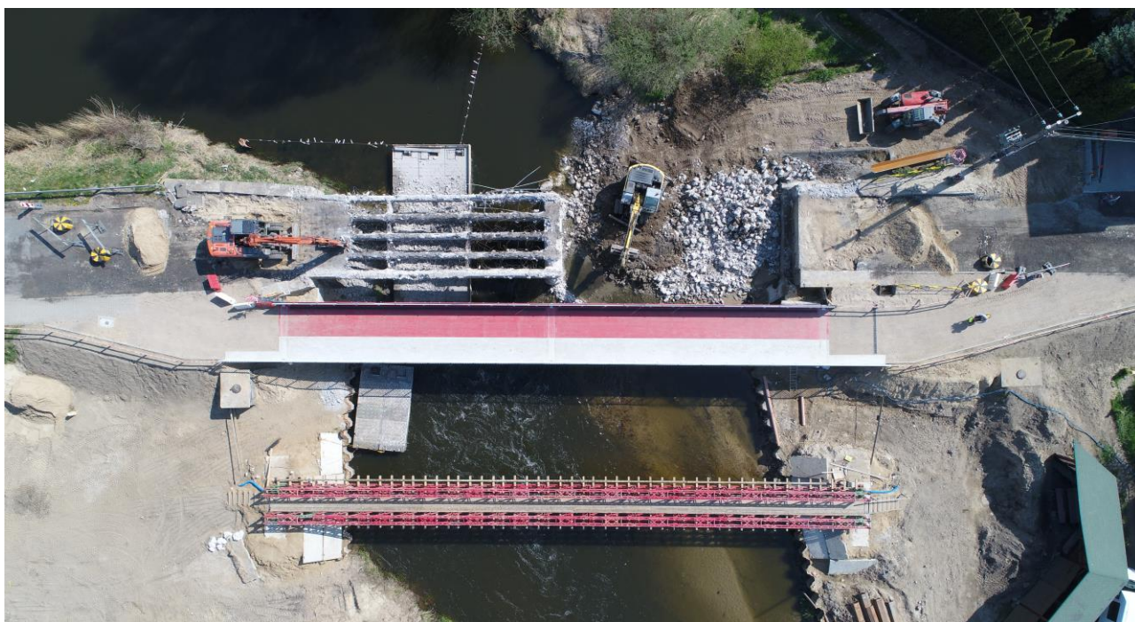
Przebudowa mostu drogowego w Kurzętniku
