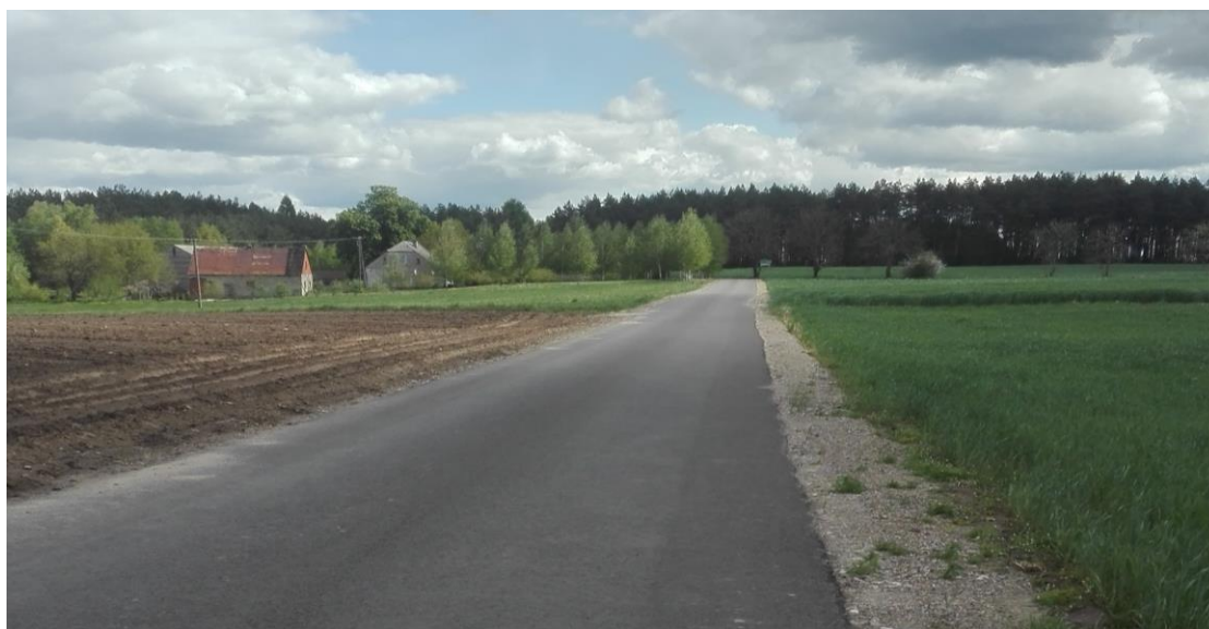
Przebudowa drogi w Tomaszewie dz. nr 183/1, 183/2 – Etap III
