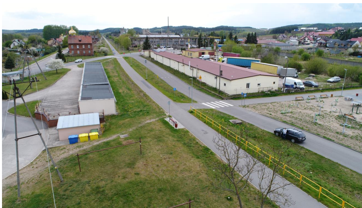
Utworzenie ścieżki rowerowej z Kurzętnika do Kaługi wraz z infrastrukturą towarzyszącą - Etap I
