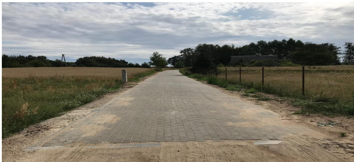
Budowa drogi gminnej na działce Nr 469/1 i 468/1 – etap II Tereszewo
