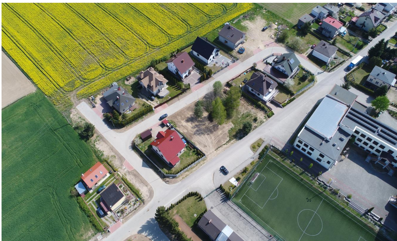
Przebudowa dróg w Marzęcicach
