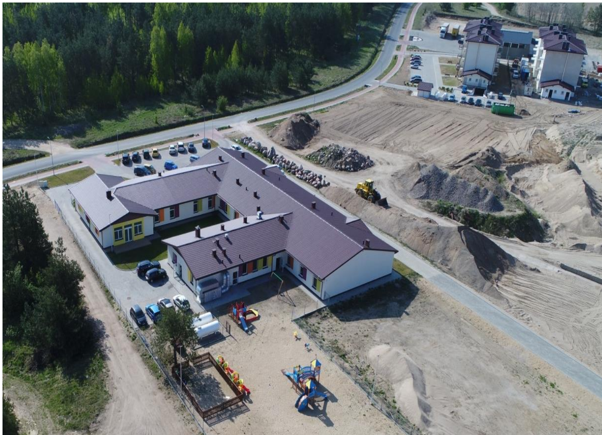
Rysunek 10. Budowa Żłobka w Kurzętniku
