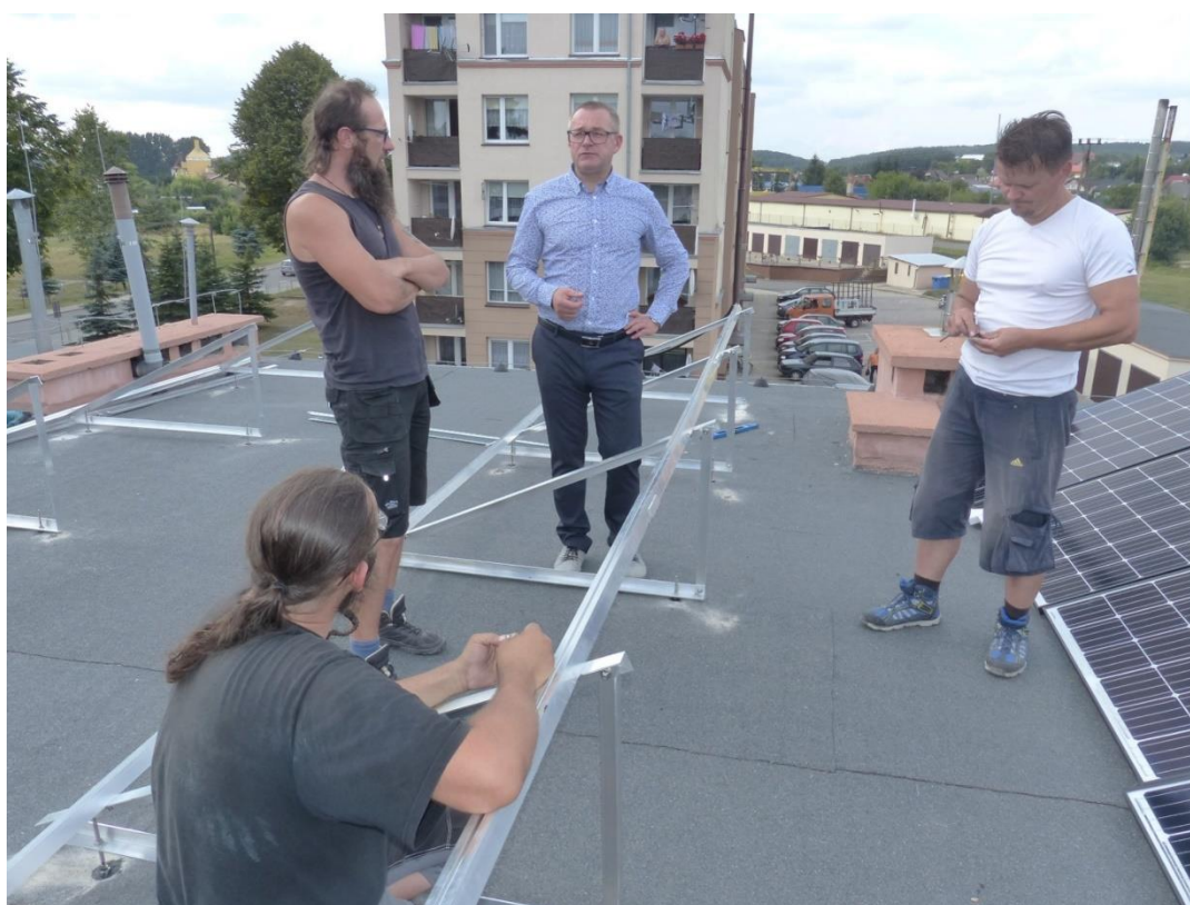
Rysunek 11. Montaż paneli fotowoltaicznych na budynku Urzędu Gminy.
