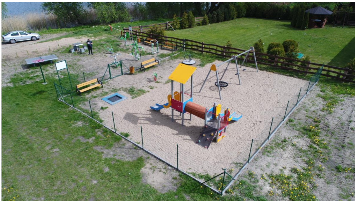
Rysunek 14. Budowa Otwartych Stref Aktywności w Gminie Kurzętnik
