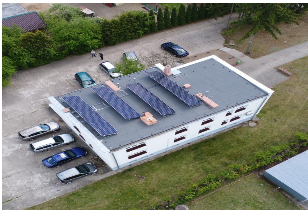
Rysunek 12 i 13. Montaż paneli fotowoltaicznych na budynku Gminnego Ośrodka Pomocy Społecznej.
