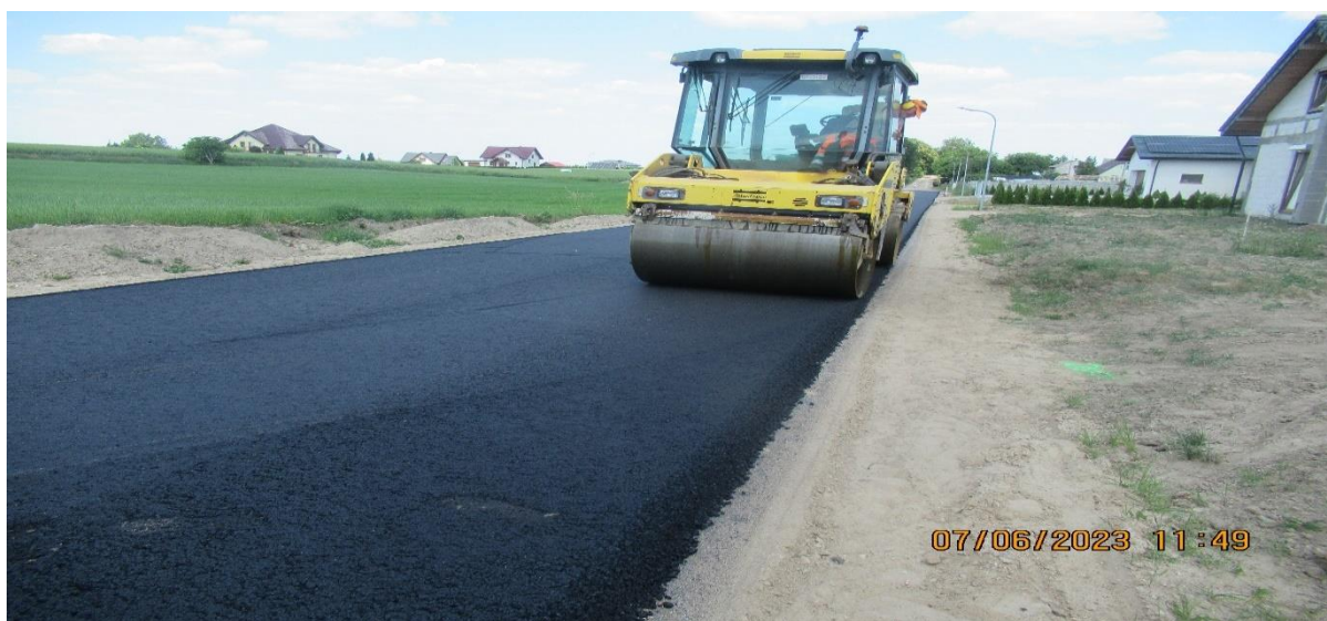
Przebudowa drogi dz. nr 473/2, 50/1 w Brzoziu Lubawskim
