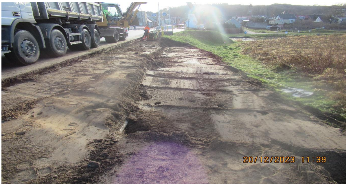
Przebudowa chodnika na ul. Dworcowej w Kurzętniku
