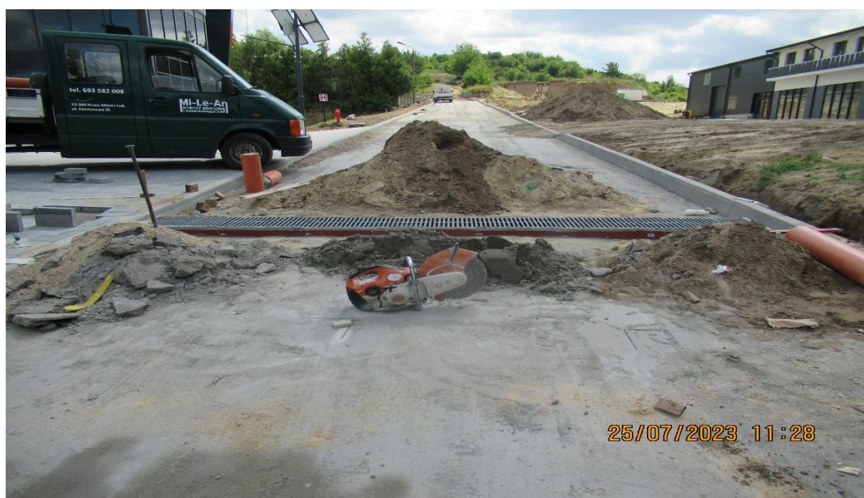
Przebudowa drogi gminnej dz. nr 1510/6 w Kurzętniku
