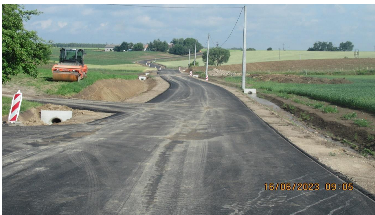
Przebudowa drogi dz. nr 473/2, 50/1 w Brzoziu Lubawskim
