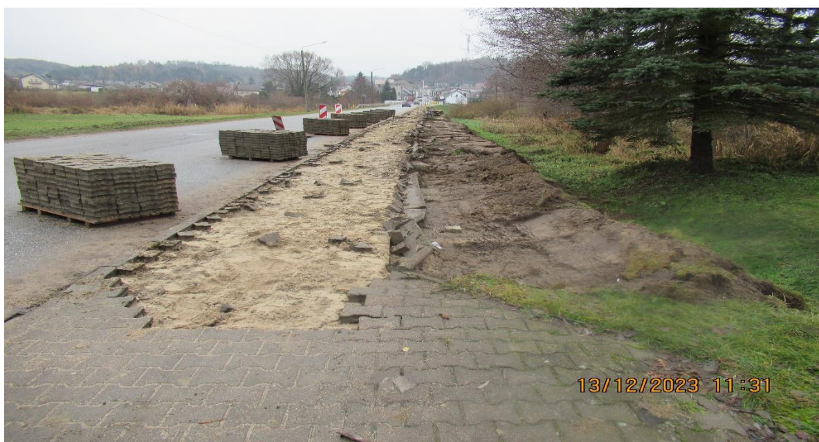
Przebudowa chodnika na ul. Dworcowej w Kurzętniku
