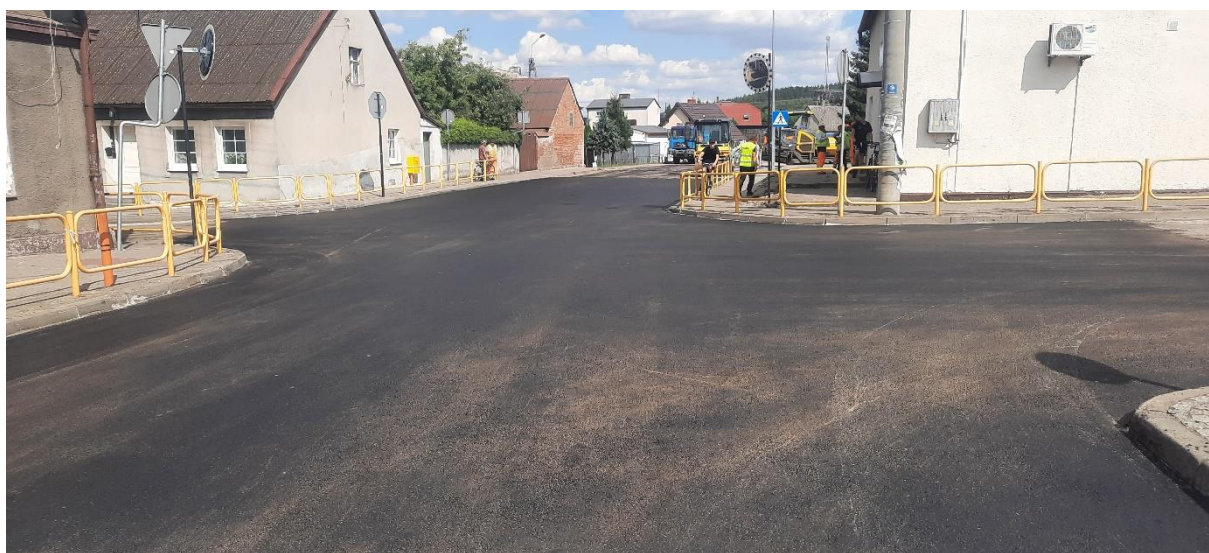
Przebudowa skrzyżowania na rynku w Kurzętniku - wykonanie nakładki
