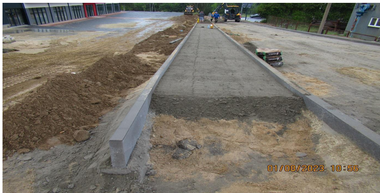
Przebudowa drogi gminnej dz. nr 1510/6 w Kurzętniku
