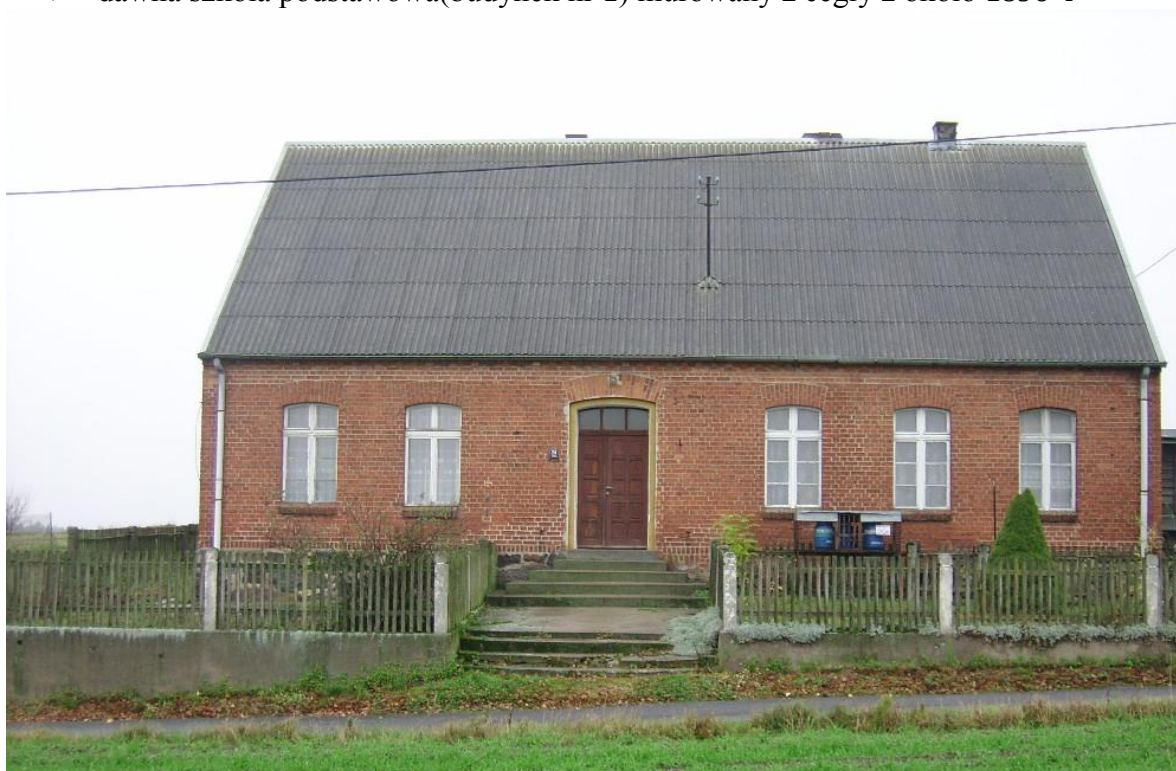
Fot.3. Budynek dawnej szkoły podstawowej
