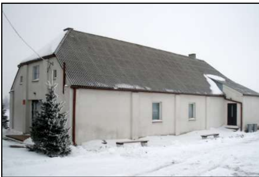
Fot. 6 Świetlica wiejska
