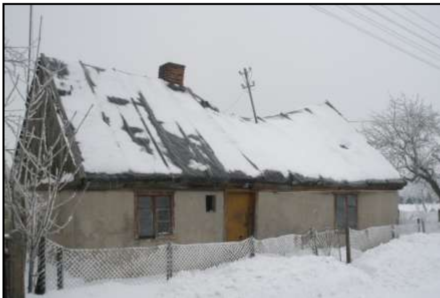
Fot. 4 Widok na budynek nr 7
