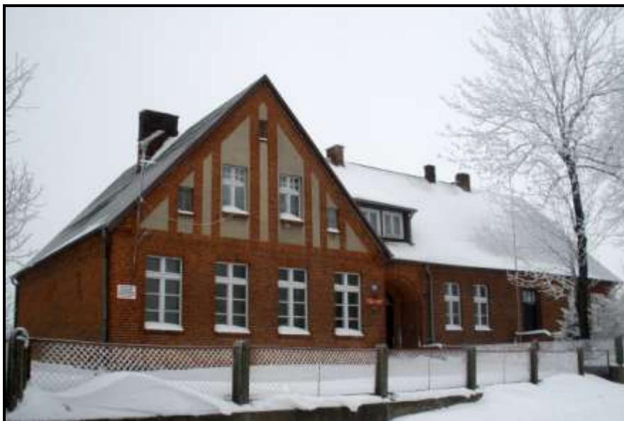
Fot. 3 Budynek dawnej szkoły podstawowej
