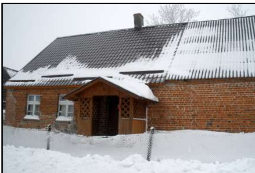
Fot. 5 Widok na budynek nr 16
