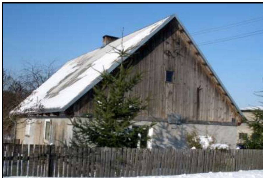
Fot. 4 Widok na budynek mieszkalny nr 2
