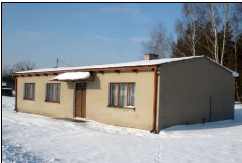
Fot. 7 Świetlica wiejska w Kącikach
