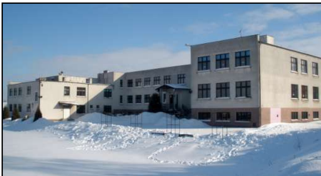
Fot. 5 Budynek Zespołu Szkół w Marzęcicach
