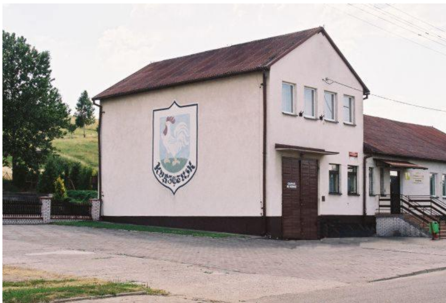
Fot. 5 Budynek Gminnego Centrum Kultury w Kurzętniku
