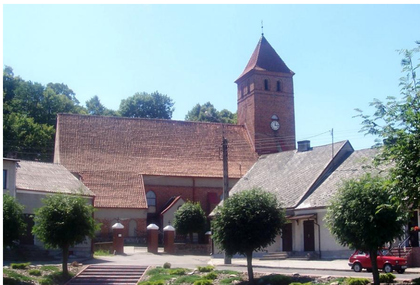
Fot. 3 Kościół parafialny w Kurzętniku
