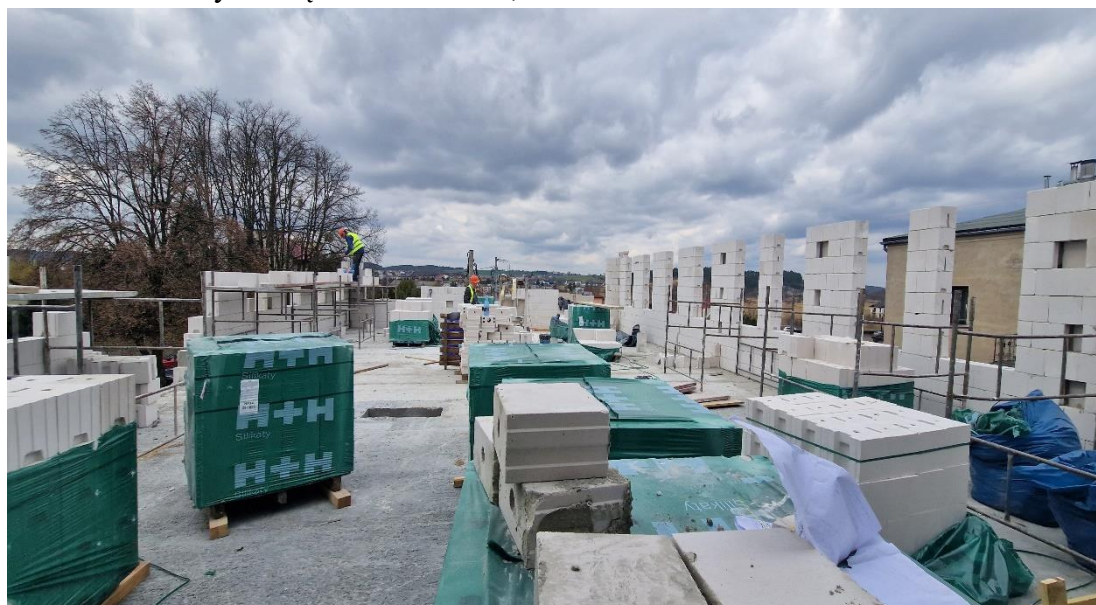
Rozbudowa budynku Urzędu Gminy w Kurzętniku
