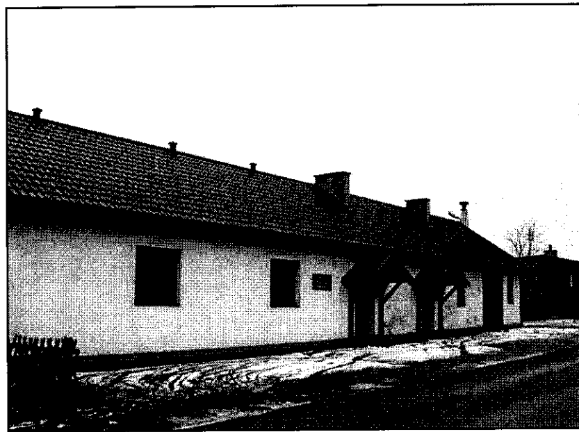
Fot. 6 Świetlica wiejska
