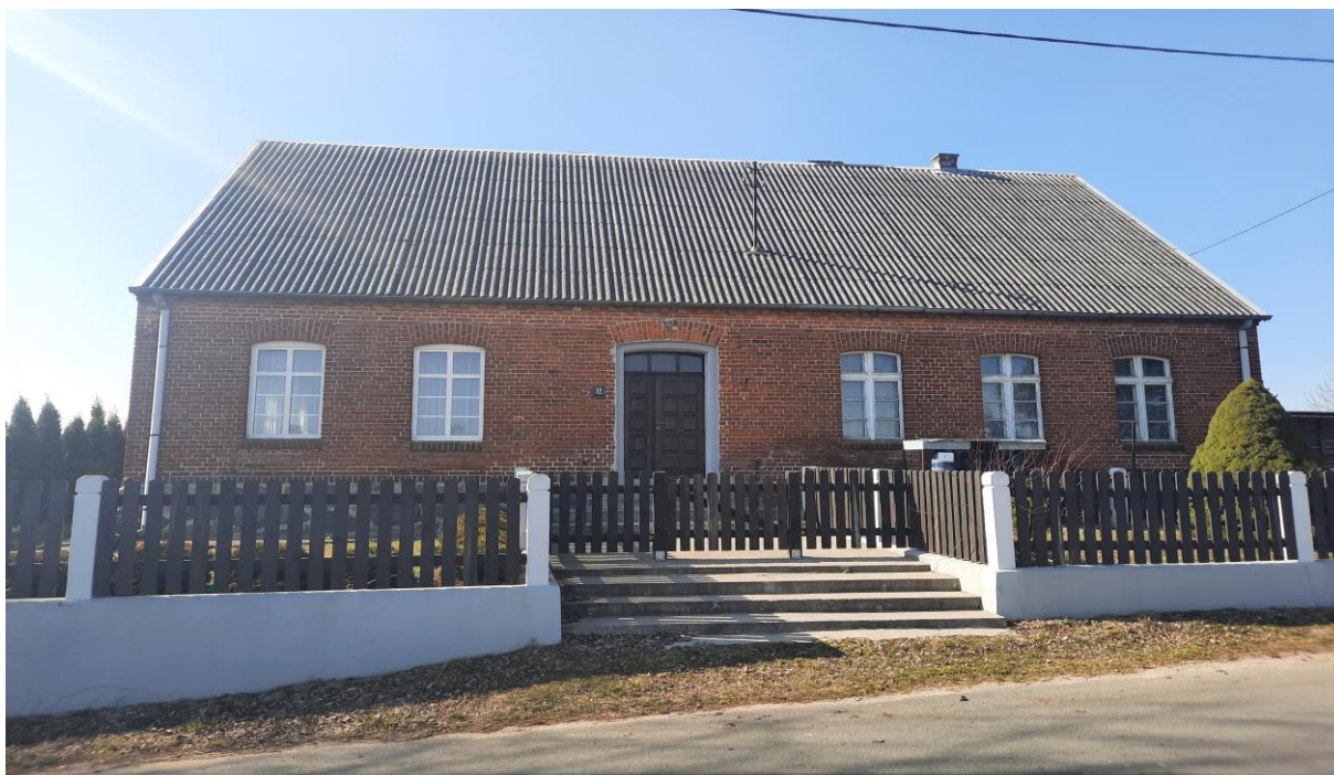
Fot.3. Budynek dawnej szkoły podstawowej - budynek nr 1 (murowany z cegły) z XIX w.
