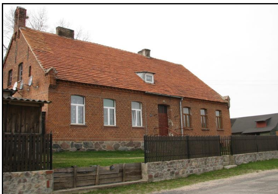
Fot. 3 Budynek dawnej szkoły podstawowej
