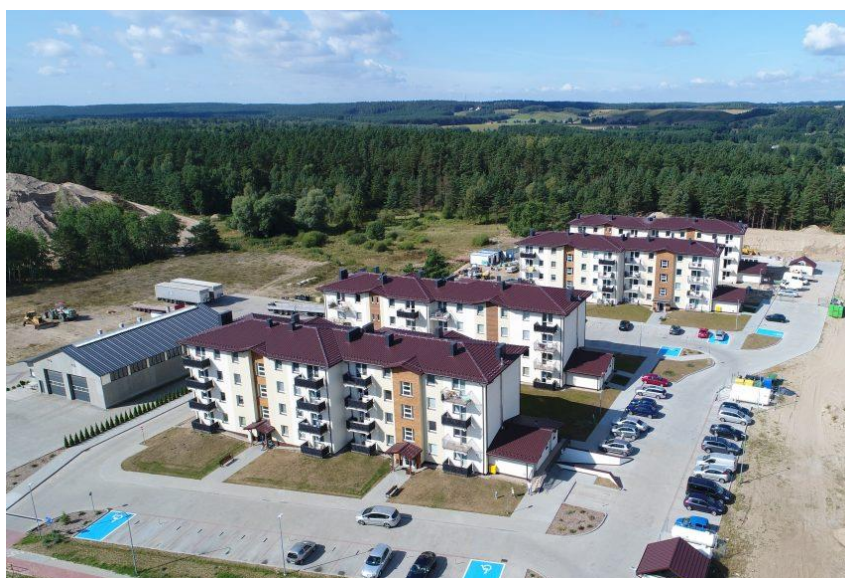
Fot. 16 Osiedle Dębno
