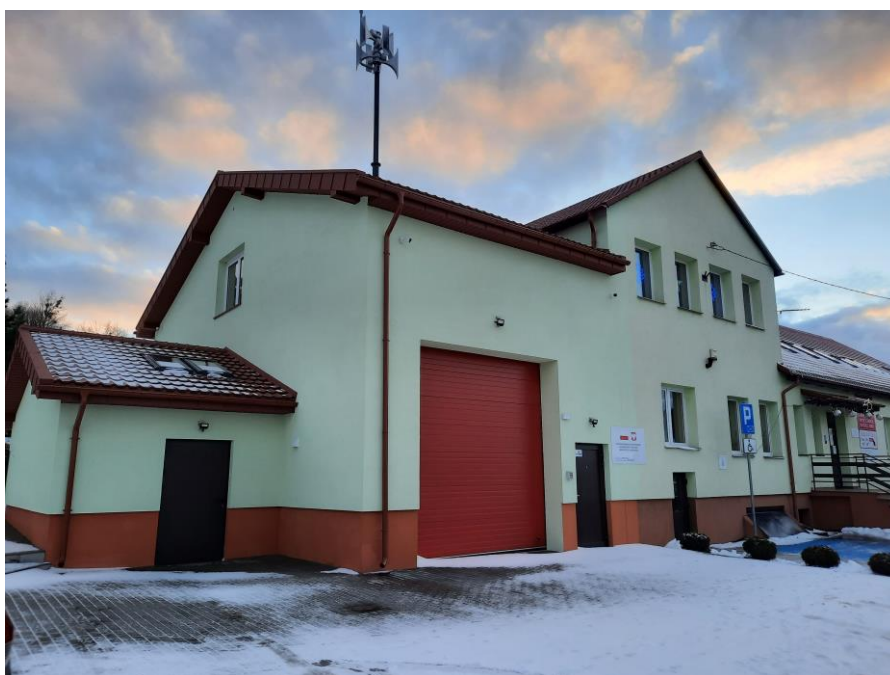
Fot. 5 Budynek Centrum Usług Społecznych oraz OSP w Kurzętniku
