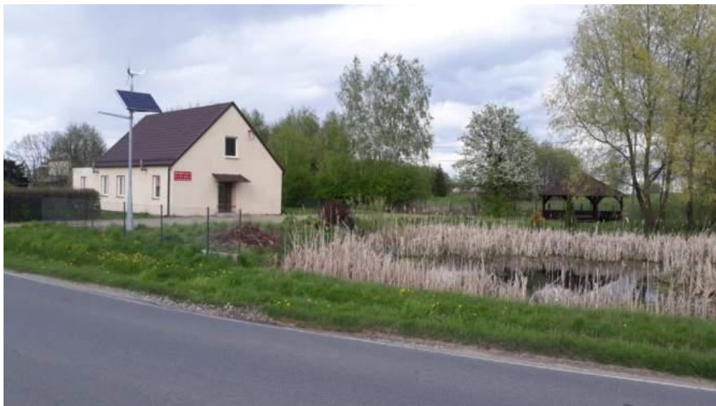
Fot. 13 Światlica wiejska z wiatą nad stawem w Wawrowicach
