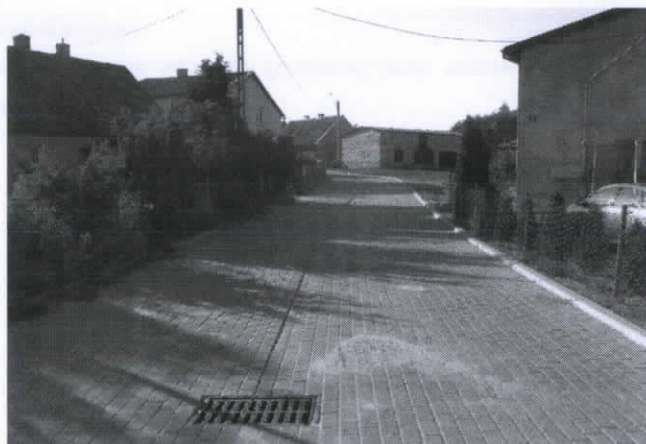
Fot. 6. Przebudowa drogi osiedlowej
