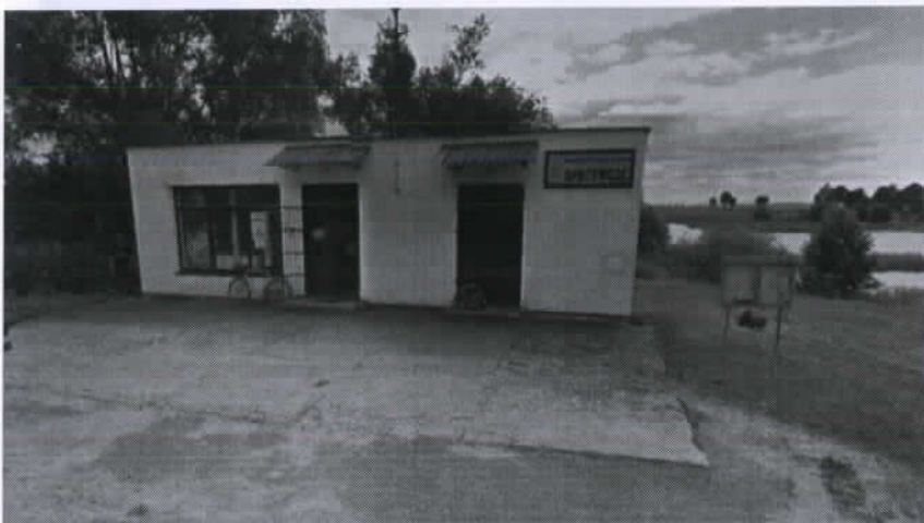
Fot. 5. Budynek dawnego sklepu przeznaczony na świetlicę wiejską w sołectwie Romanowo
