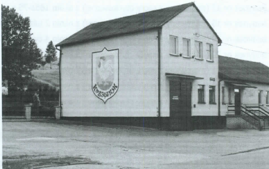
Fot. 5 Budynek Gminnego Centrum Kultury w Kurzętniku
